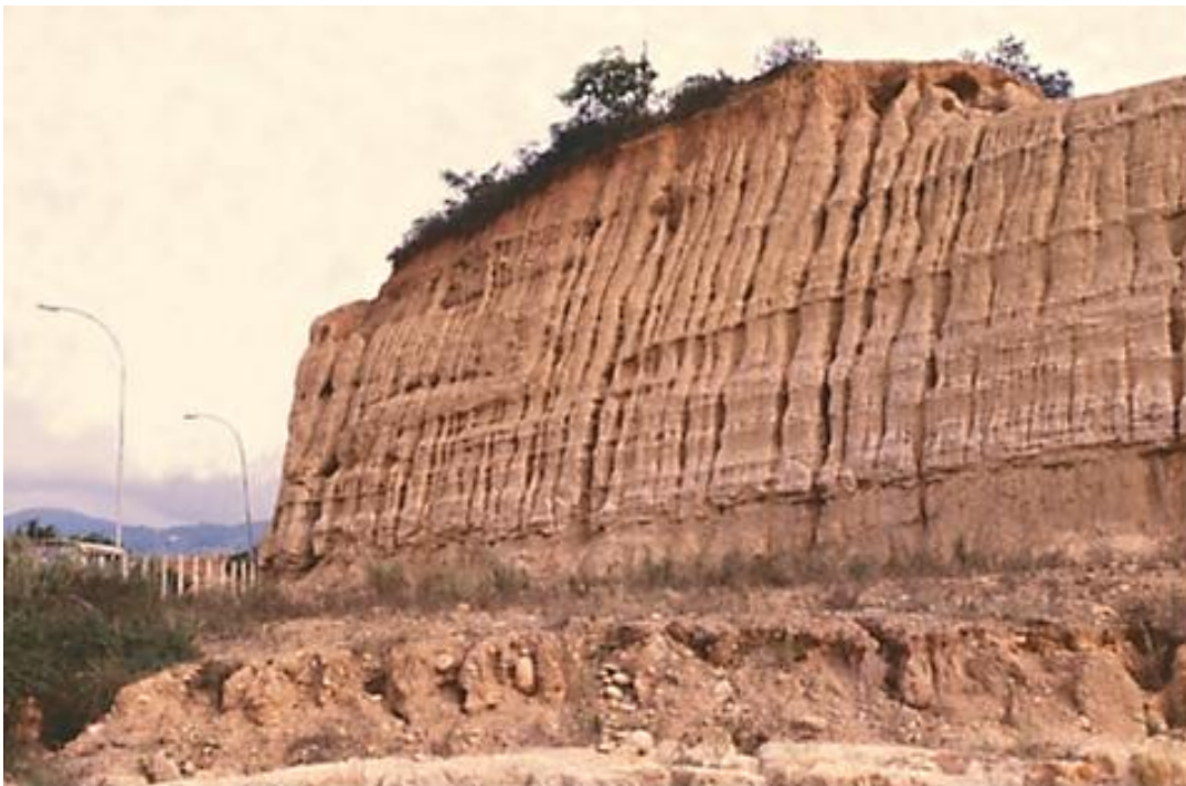
Figura 6. Erosión en surcos.
