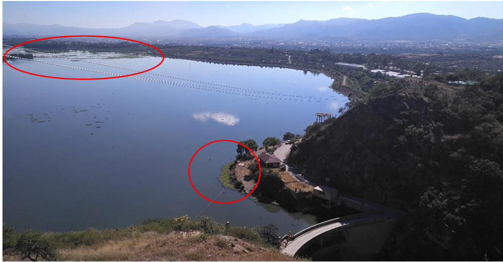
Figura 2.1: Vista presa San Jacinto
