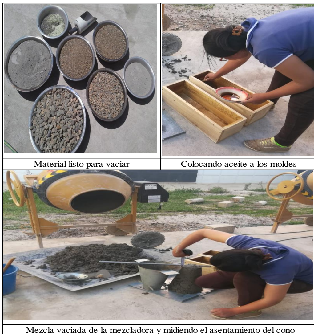
Figura N° 32: Material listo para vaciar vigas
