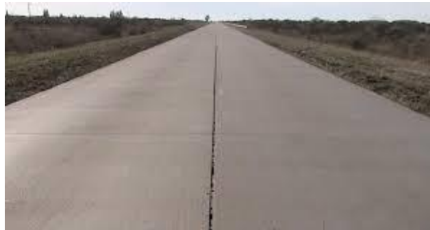
Figura N° 36: Juntas longitudinales
