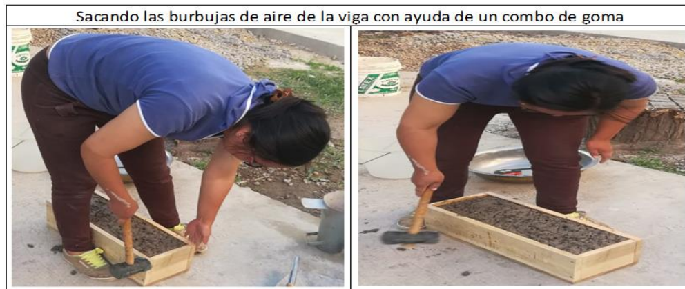
Figura N° 33: Sacando las burbujas de aire de la viga
