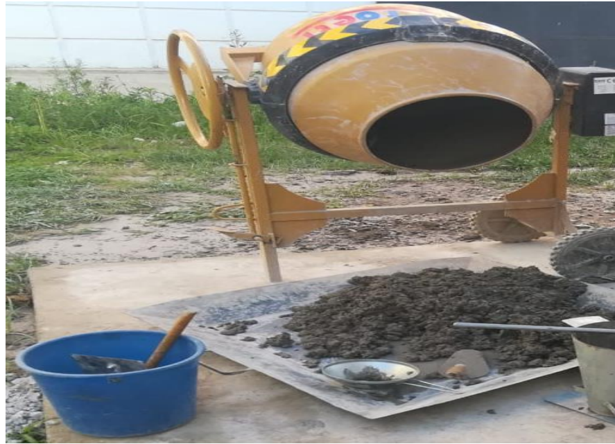
Figura N° 28: Vaciado la mezcla de la mezcladora a una fuente
