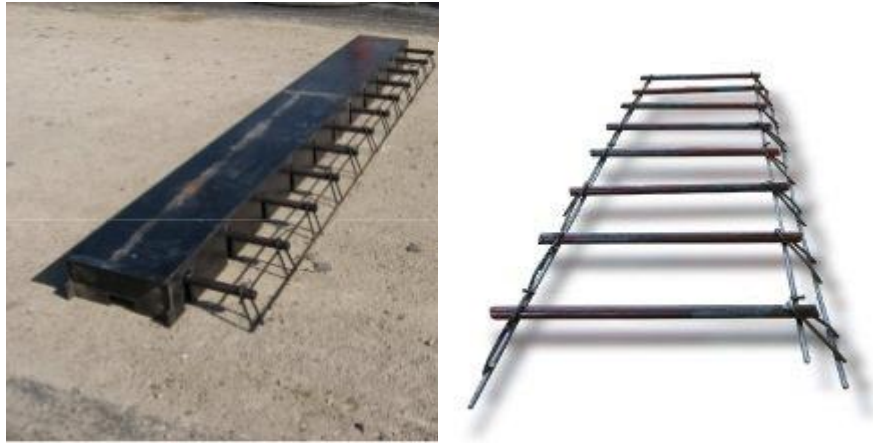
Figura N° 35: Juntas transversales
