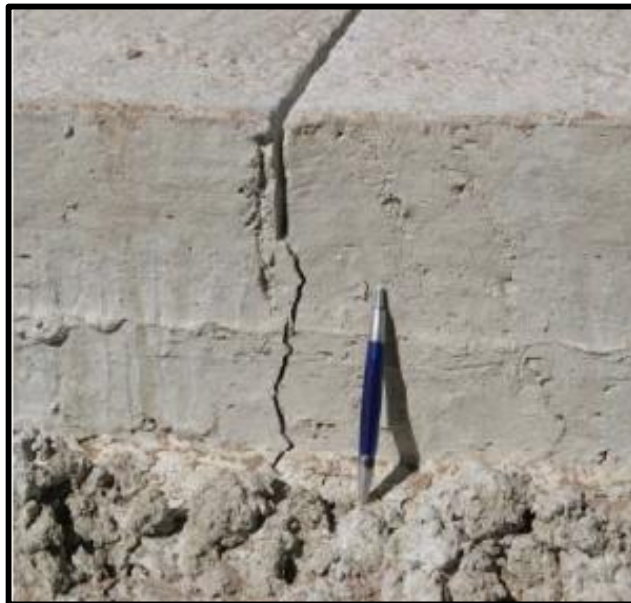
Figura 2. 11. Transferencia de carga mediante trabazón de agregados
