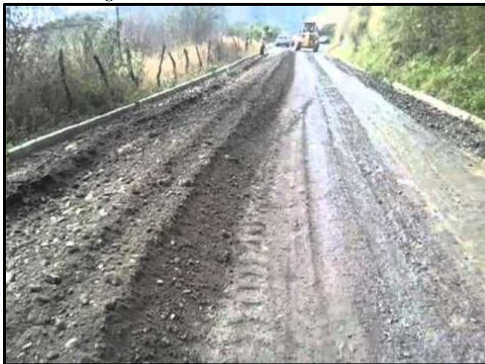
Figura 2. 13. Bases estabilizadas con cemento
