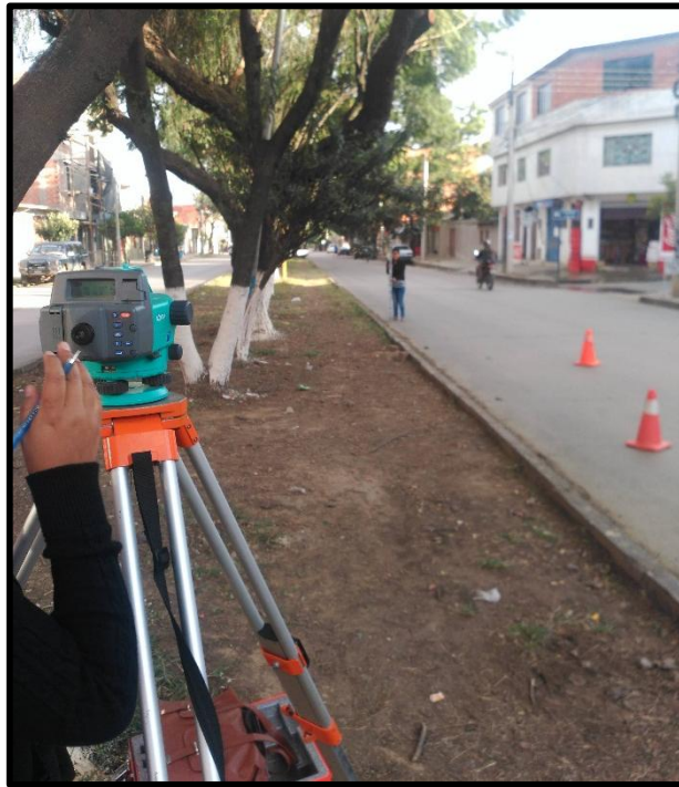
Figura 3. 15. Estado inicial de medición
