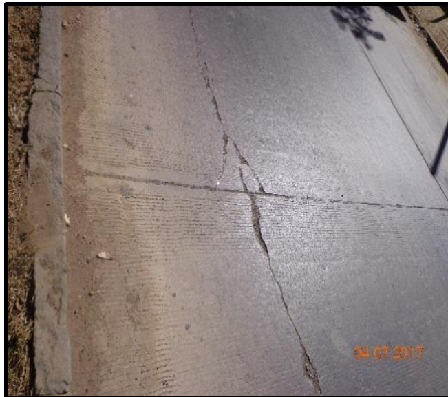
Figura 2. 14. Grieta longitudinal
