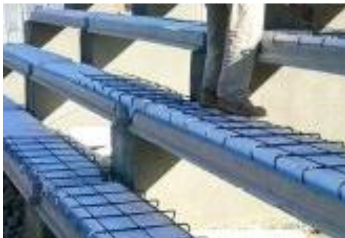
Ilustración 46 Losa aligerada con vigueta pretensada
