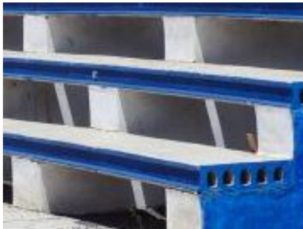
Ilustración 48, Losa hueca Fuente: Archivo Fotográfico A. Del Castillo – Obra en Cancha de Barrio en El Alto
