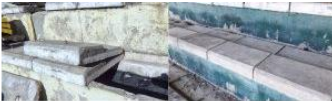
Ilustración 47, losa prefabricada, Fuente: Archivo Fotográfico DTC TECNOPRECO – Obra vendida en La Paz – Estadio Hernando Siles
