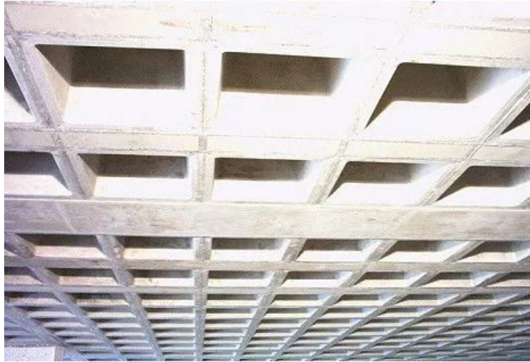
Ilustración 12, Losa casetonada o reticular, Fuente: Internet www.losa.casetonada.com
