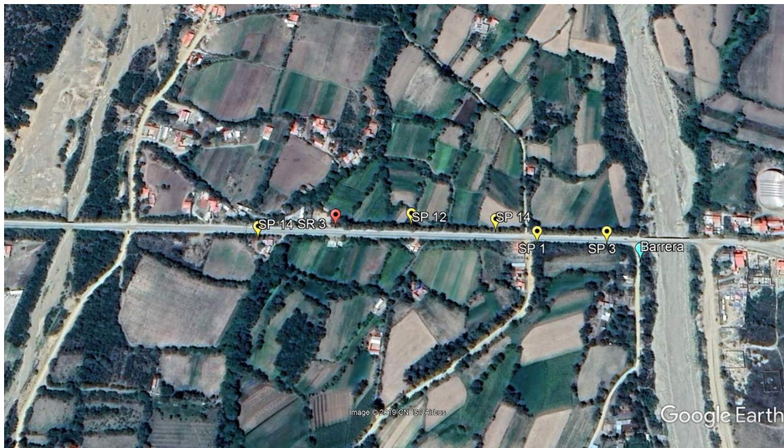
Figura N° 58 Implementación de las señales de tránsito
