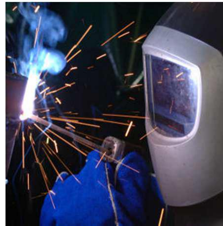
SOLDADURA POR ARCO ELÉCTRICO
