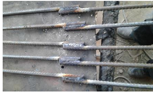
Foto 3.7. Soldadura de relleno
