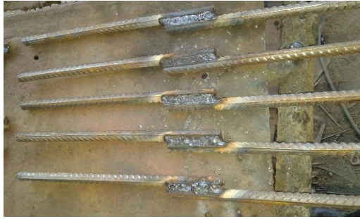
Foto 3.6. Soldadura de raíz
