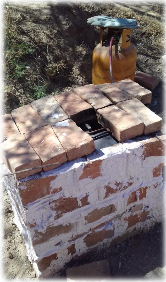
Muro de ladrillo gambote con yeso
