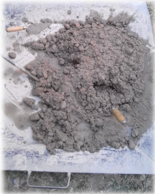
Preparado del hormigón
