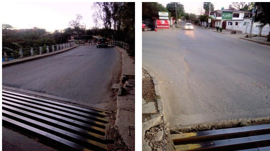
Imagen 3.1: Tramo Puente de Tomatitas carretera a San Lorenzo
