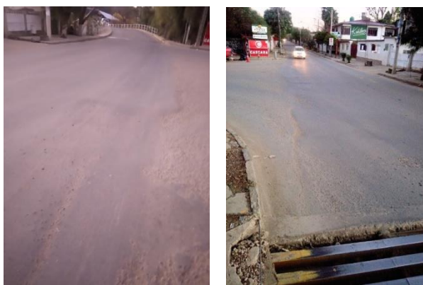
Imagen 3.37: Identificación del sitio de la extracción de núcleos- Tramo 1
