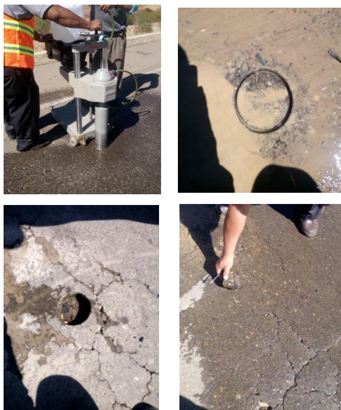
Imagen 3.40: Extracción de muestras de los dos tramos
