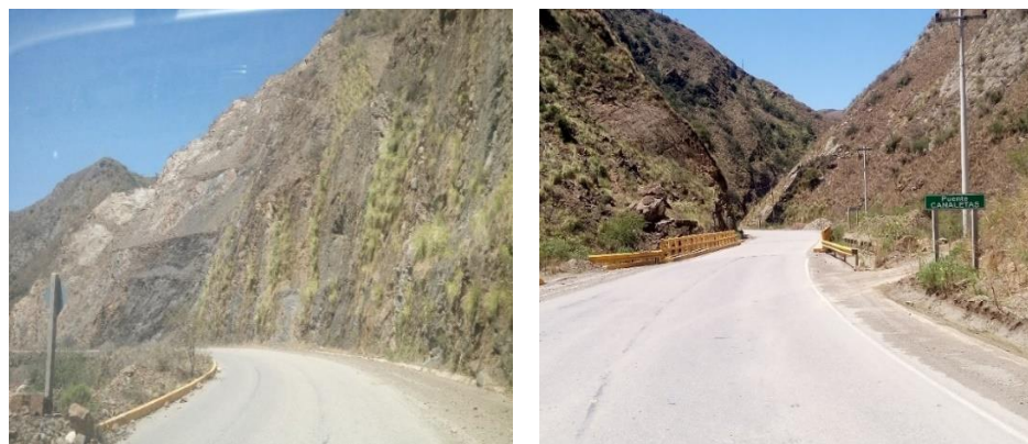
Imagen 3.3: Tramo Piedra Larga – Canaletas
