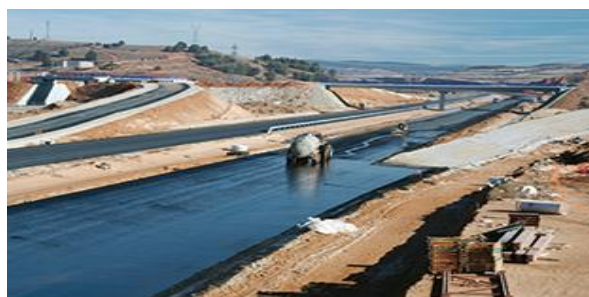
Imagen 2.13: Aplicación de geosintético como barrera impermeabilizante
