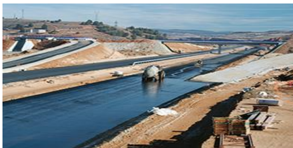
Imagen 2.13: Aplicación de geosintético como barrera impermeabilizante
