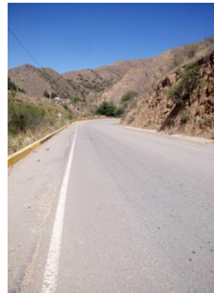
Piedra Larga – Canaletas
