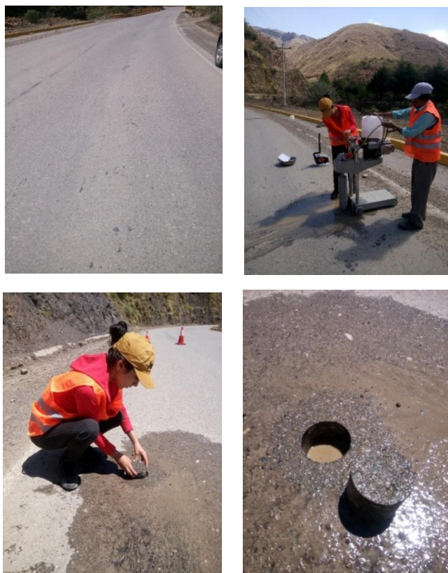
Imagen 3.41: Identificación del sitio y extracción de núcleo- Tramo 3
