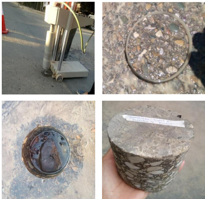
Imagen 3.38: Extracción de núcleo del sitio
