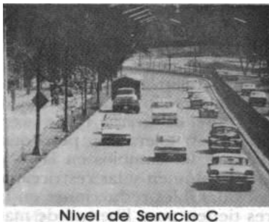
Figura 5: Nivel de servicio C
