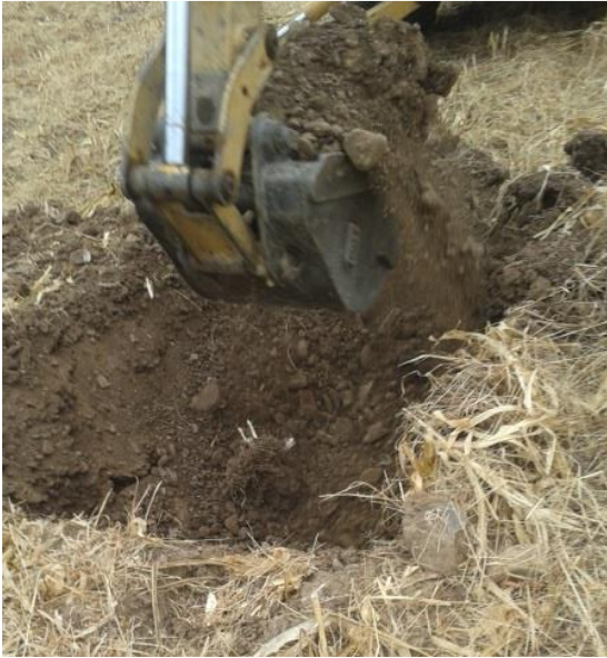
Excavación pozo de observación
