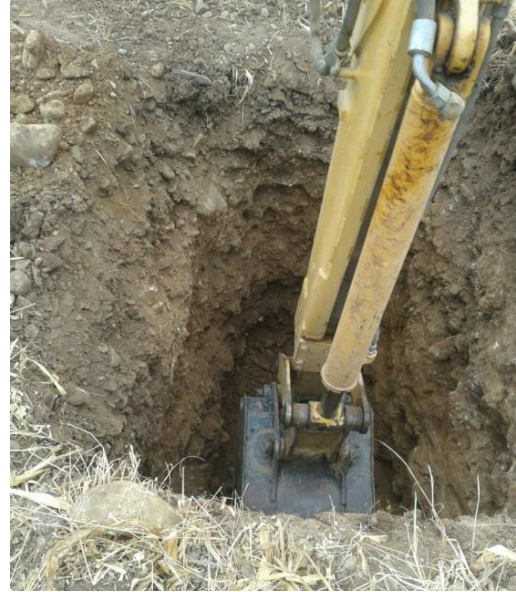
Excavación pozo de observación
