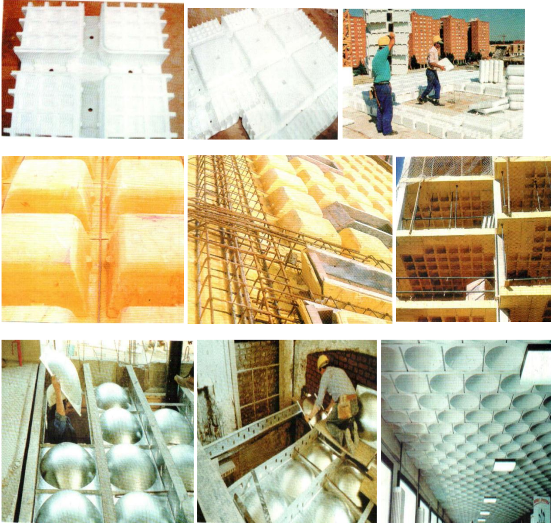
Fig. 4.3 Forjados reticulares con Casetones de Aligeramiento Especiales
