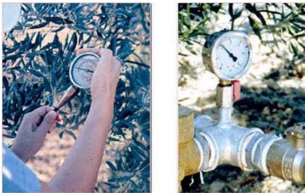
Figura 2-19 Medidores de presión.
