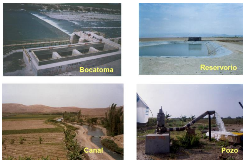
Figura 2-9 Fuentes de agua utilizadas en sistema de riego tecnificado
