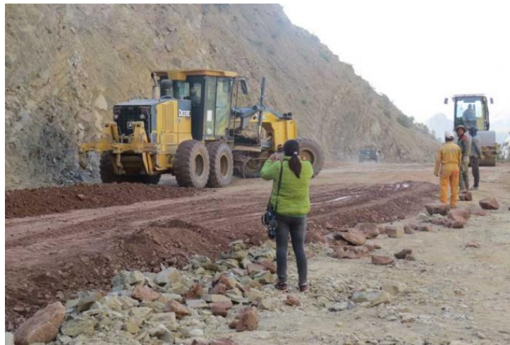
Figura 13 - Subbase de una carretera
