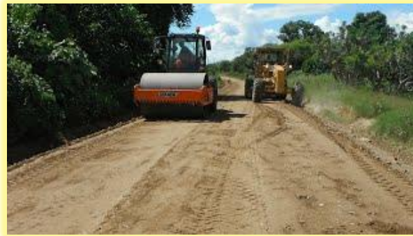
Figura 12 - Base de una carretera
