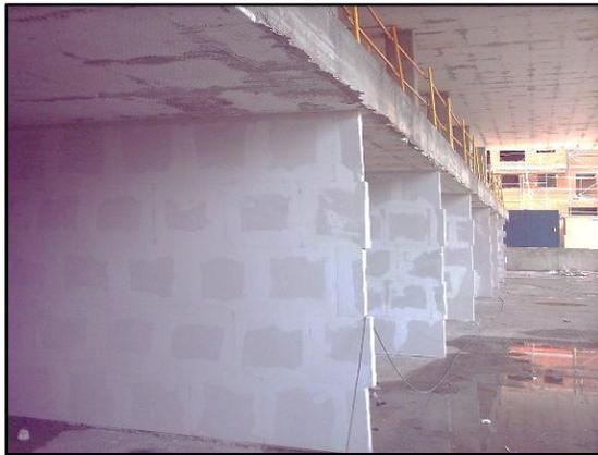
Figura 5.7. Muro de hormigón aligerado como separador de ambientes
