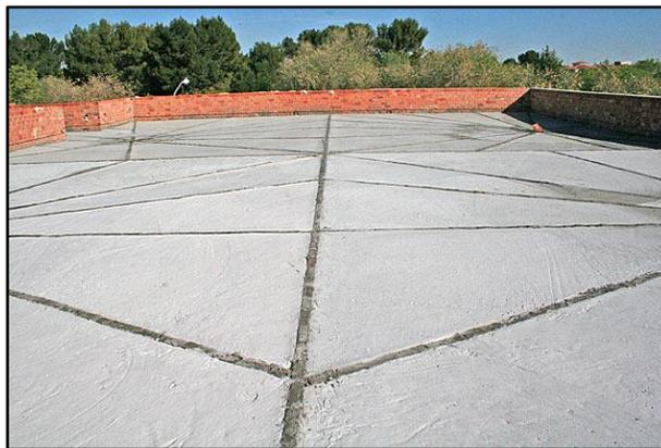
Figura 5.6. Azotea rellena con hormigón aligerado
