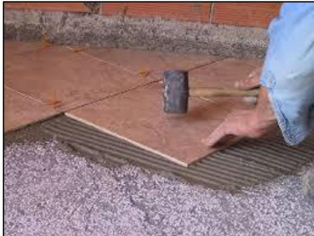
Figura 5.4. Piso cerámico fijado con pegamento especial
