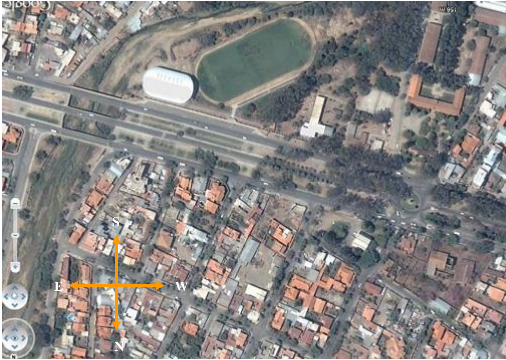
Figura 4.1 Fotografía aérea del tramo en estudio
