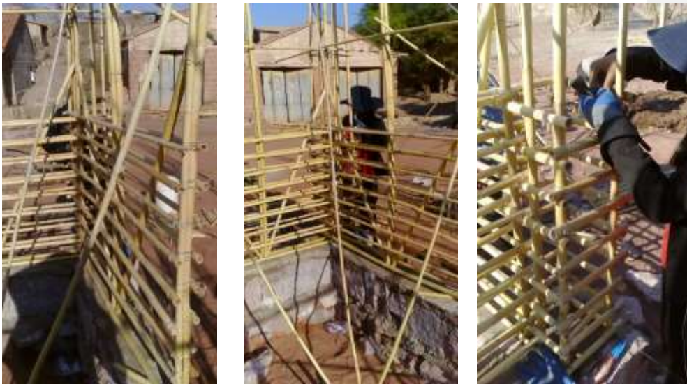
Aplicación del amarro de caña para realizar el muro de bahareque.
