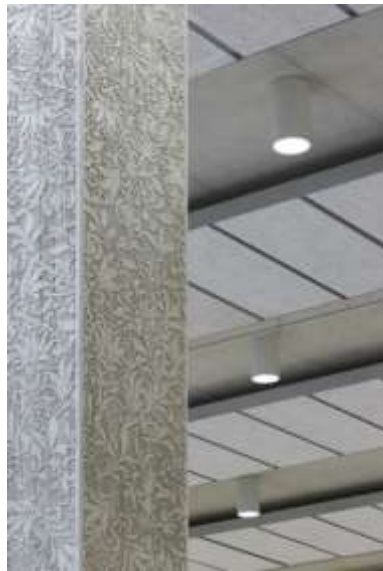
IMAGEN 94 DETALLE DE COLUMNAS DE LAS ARTES
