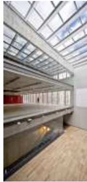
IMAGEN 84 VISTA DE LA ESTRUCTURA DE LA FILMOTECA DE CATALUNYA
