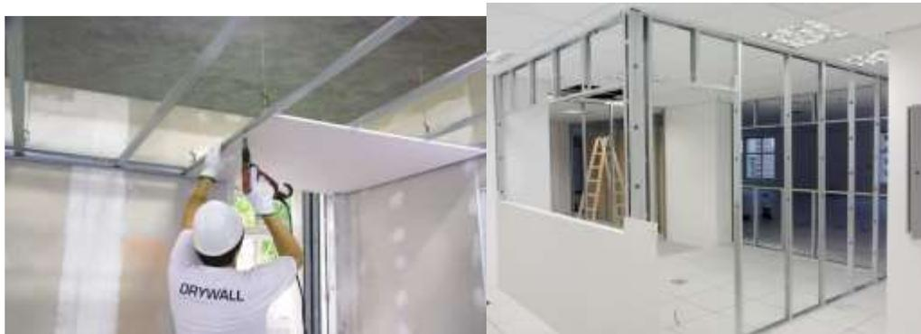
Es un material de construcción utilizado para la ejecución de tabiques interiores y revestimientos de techos y paredes. Se suele utilizar en forma de placas, paneles o tableros industrializados. Consiste en una placa de yeso laminado entre dos capas de cartón, por lo que sus componentes son generalmente yeso y celulosa aprovechándose de la buena resistencia a la compresión del yeso con la buena resistencia a la flexión que le da el sándwich de cartón.
