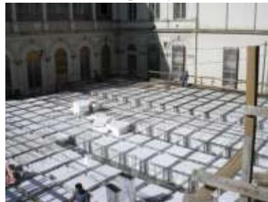
Las losas casetonadas son aquellas losas formadas por un reticulado de vigas las cuales se vinculan por medio de losas. Es la que se realiza colocando en los
