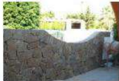
MUROS DE PIEDRA:
