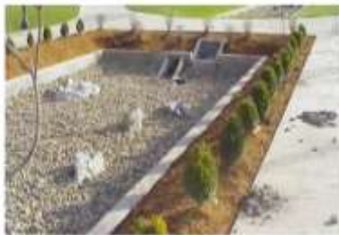
Imagen 11. Filtro de arena (Fuente: City of Sandy. http://www.ci.sandy.or.us/verticalfarm%7E0011814D-3A64-4211-87C3-B13000000115?Vignette%7E0211293E-F304-4036-8033-F08120000115%7D.JPG )
