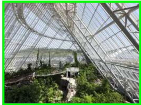
intermedia ionoplastico N-UV SentryGlas ® vidrio de seguridad con alta transmisión de la luz natural que es resistente a los huracanes. Se trata de una solución tecnológica ya probada que le permiten construir vidrios arquitectónicos con un factor de transmisión de UV sin precedentes, lo que permite llegar a un nivel de iluminación natural del conjunto.
