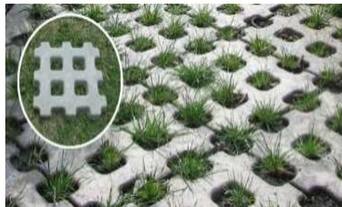
de vehículos no afecte el buen estado del césped, y que además éste, quede visible por sobre las baldosas, de esa manera se logran veredas verdes que garantizan el crecimiento del césped con total libertad. Estas baldosas son muy fáciles para colocarlas, ya que no requieren la construcción de un contra piso como base, primero se necesita, que el suelo este firme y compacto, para que sirva de suficiente apoyo para instalar las baldosas
