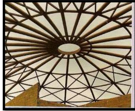
Pero si se trata de estructuras articuladas, tal el caso normal en estructuras metálicas, se hace necesario rigidizar la estructura a través de triangulaciones (llamadas cruces de San Andrés), o empleando pantallas adicionales de hormigón armado
