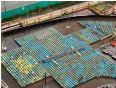
Esferas y discos de material reciclado. El material utilizado es un producto de desecho que contamina el ambiente. Lo reciclamos para producir las esferas y discos, que quedan perdidos dentro de la masa del hormigón.
