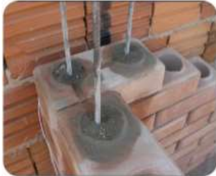
Bloques de ladrillos con mortero
