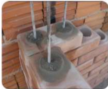
Bloques de ladrillos con mortero
