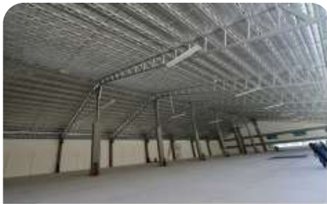
Estructura de cubierta ( cerchas metálicas de doble perfil metálico 125mm. x 80mm.)
