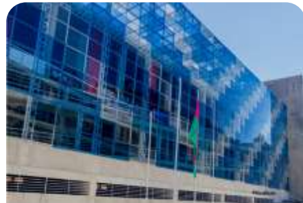
Fachada principal con vidrio laminado e= 0,9mm.
