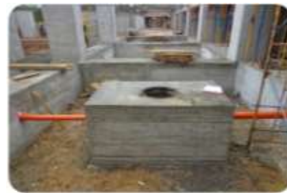
Vigas conectadas de forma horizontal en el terreno
