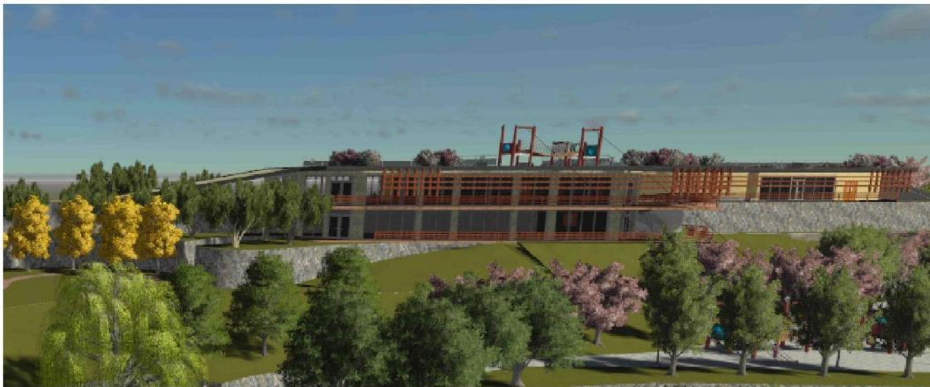
FACHADA FRONTAL BLOQUE "C"
