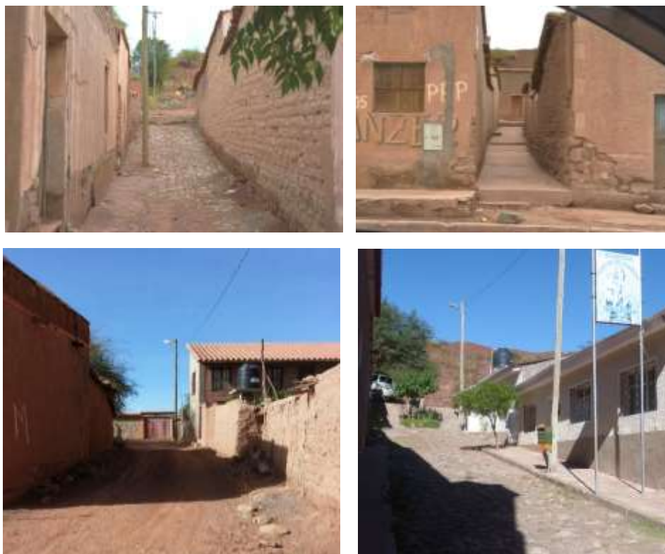
Vista actual Pasajes –Zona 3 - Las Carreras
