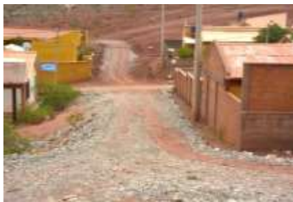
Vista actual calle s/n – Z1
