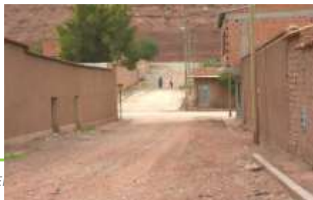
Vista actual calle s/n – Z3
