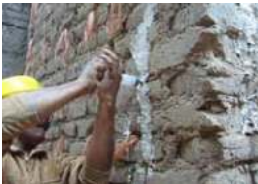
INYECCION DE "LECHADA" DE CAL
