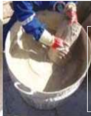
LIMPIEZA Y TRATAMIENTO DE TEJAS ANTIGUAS, CON AGUA DE CAL Y PENCA
