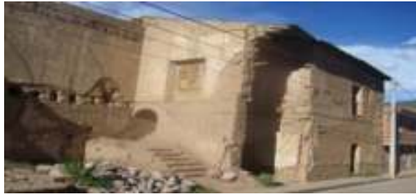
VIVENDA EN LA CALLE 25 DE MAYO, INGRESO AL TERRENO (RUINAS)
