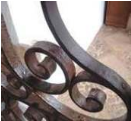
EJEMPLO DE HIERRO FUNDIDO DESPUES DE SU LIMPIEZA Y ENCERADO
