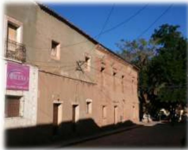
ENTRADA POR LA CALLE GRAU.
