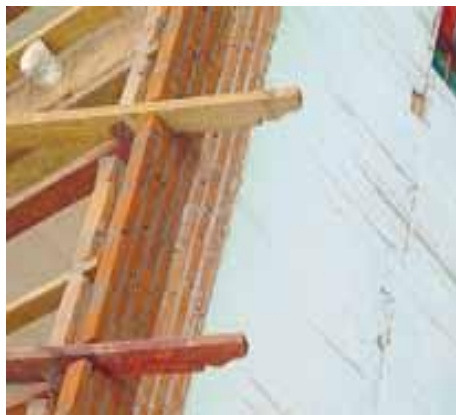
REFUERZO DE CAMA POR LADRILLO
