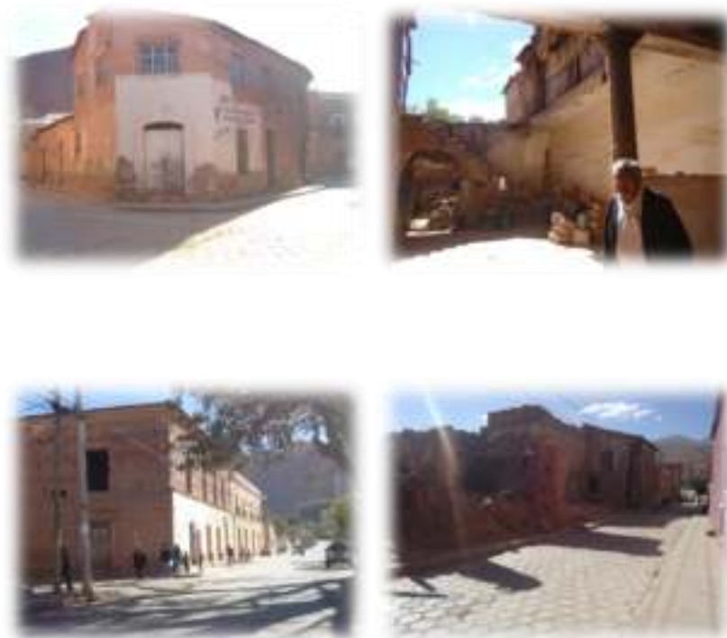
VIVIENDAS DEL CENTRO DE LA CIUDAD EN DETERIORO
