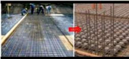
Losas sin vigas, aliviada con esferas o discos.
