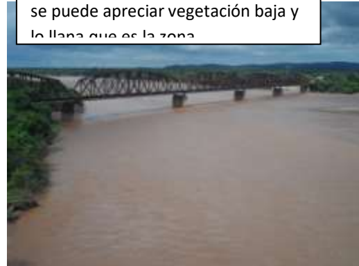
Imagen desde el puente nuevo donde se observa el puente ferroviario
