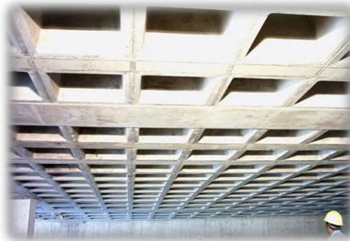
**La losa alivianada.**- por vigueta pretensada, permite lograr una gran reducción en material y mano de obra a emplearse en la edificación, por la versatilidad del sistema constructivo y la rigidez de la prefabricación en viguetas de hormigones de alta resistencia con cable como alma estructural, es sin duda el método más factible para realizar losas
