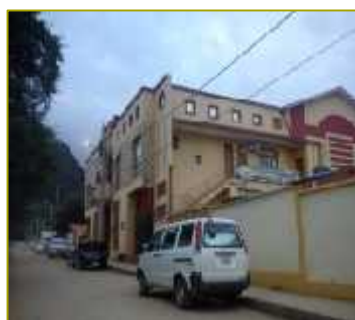
Sub prefectura Padcaya
