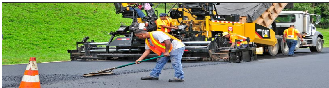
Figura N° 2.1. Mezcla asfáltica puesta en obra
