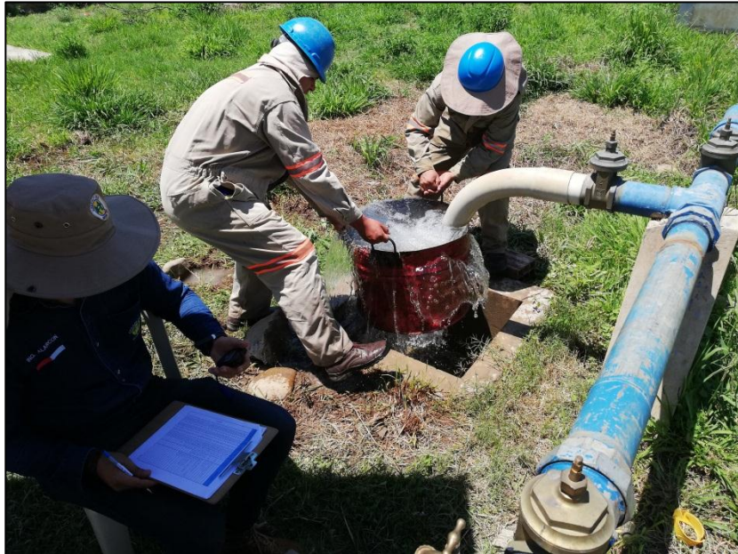
AFORO DE CAUDAL EN POZO DE PRODUCCIÓN STADIUM PN
