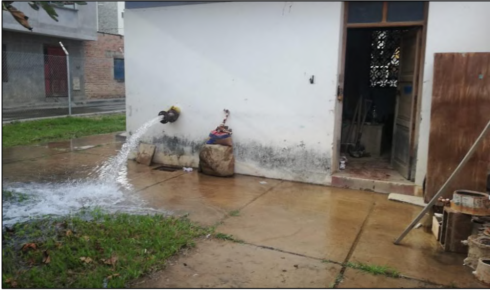
VISTA ANTES DE CONSTRUIRSE LA CÁMARA PARA DESAGUE DEL POZO DE PRODUCCIÓN VILLA FÁTIMA B
