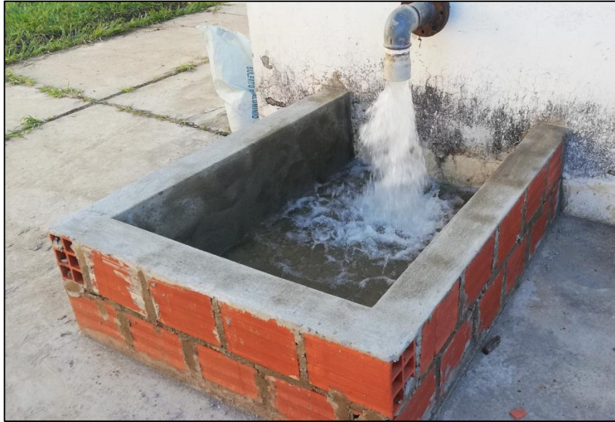
CÁMARA DE DESAGUE ADAPTADA AL SITIO DE LA PRUEBA DE BOMBEO
