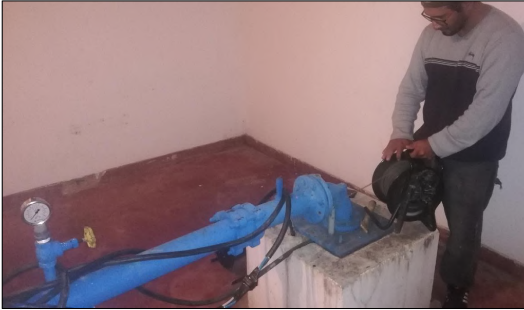
TOMA DE DATOS DE NIVELES PIEZOMÉTRICOS EN EL POZO MORROS BLANCOS A POZO DE OBSERVACIÓN
