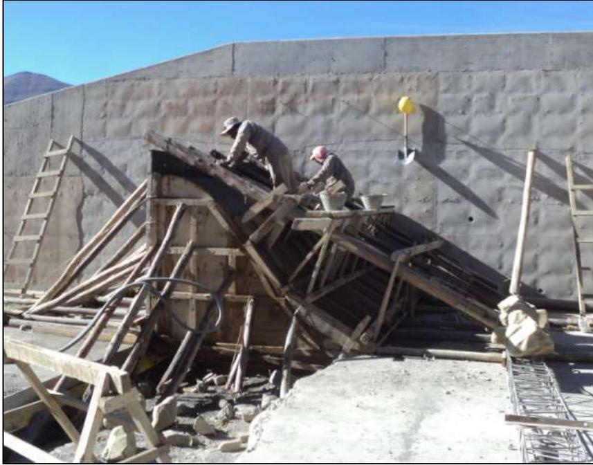
**Figura 4.2. Construcción del vertedero tipo Creager**
