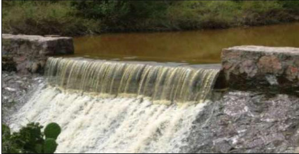
**Figura 2.7. Vertedor de caída recta y descarga directa**
