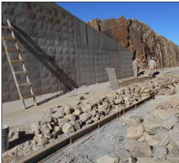
**Figura 4.1. Construcción del vertedero de excedencias**
