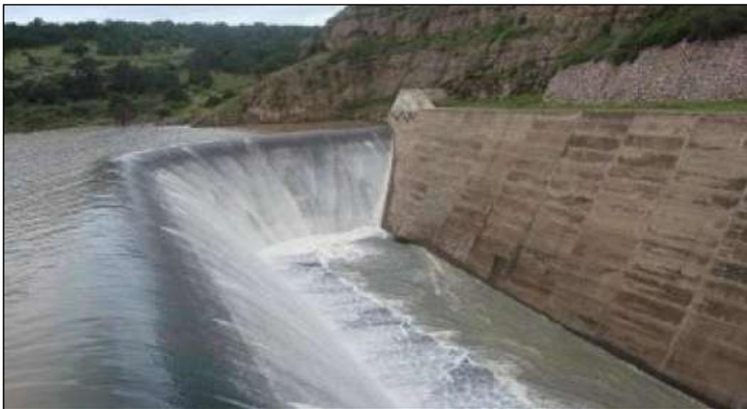
**Figura 2.8. Vertedor de cimacio con canal lateral**
