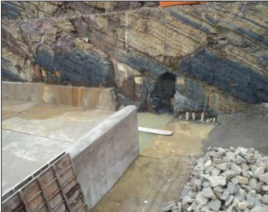
**Figura 3.2. Construcción del vertedero Creager**
