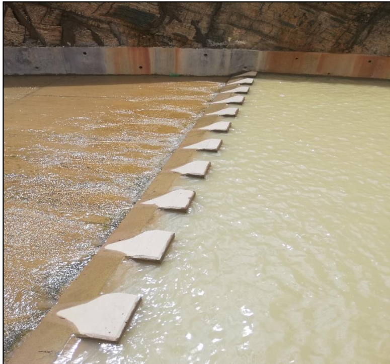
Fotografía 16. Disipador de energía al inicio del canal de descarga
