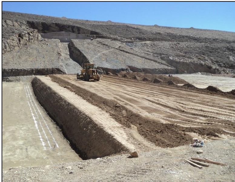
Fotografía 6. Relleno y Compactado Núcleo de Arcilla
