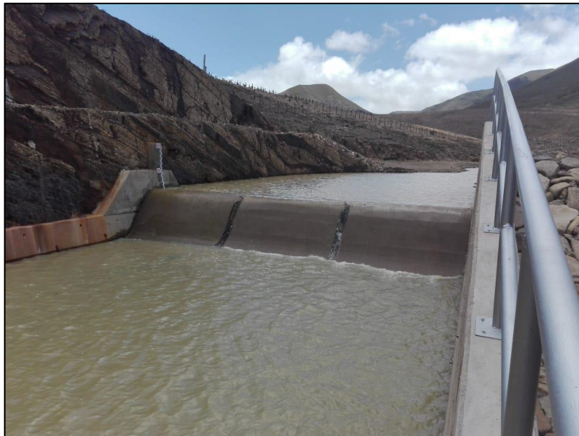
Fotografía 14. Vertedero de excedencias
