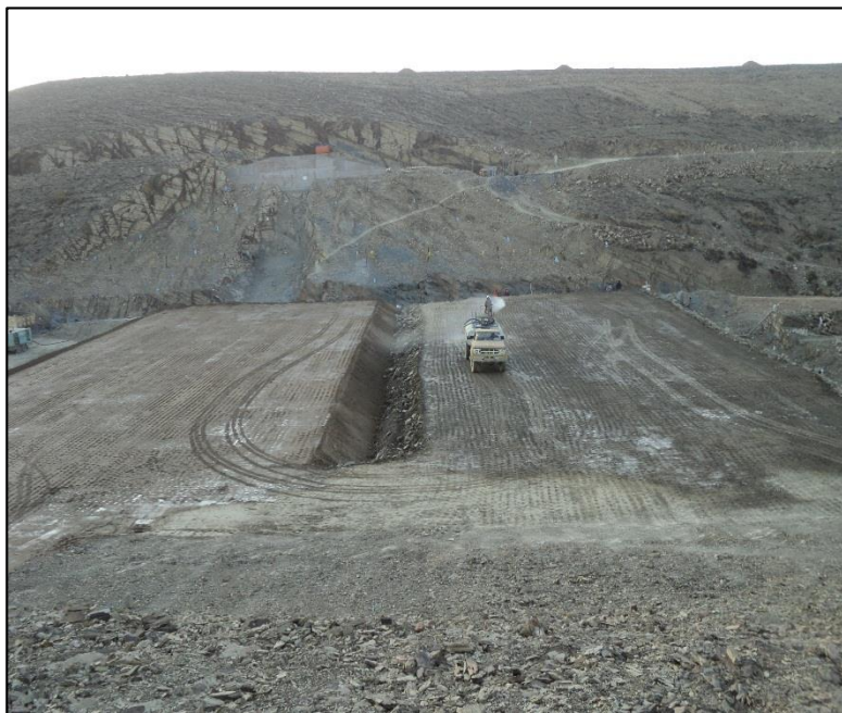
Fotografía 2. Relleno y Compactado de Espaldón (Aguas Arriba)
