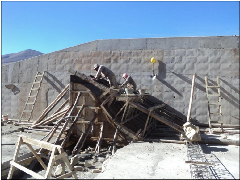
Fotografía 7. Construcción del Perfil Creager
