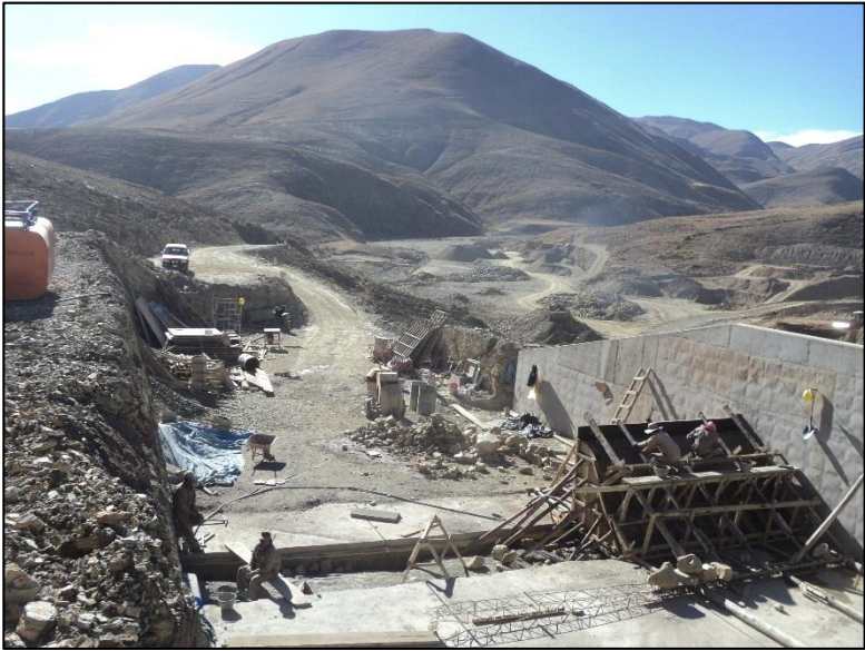
Fotografía 8. Construcción del Vertedero de excedencias vista aguas arriba
