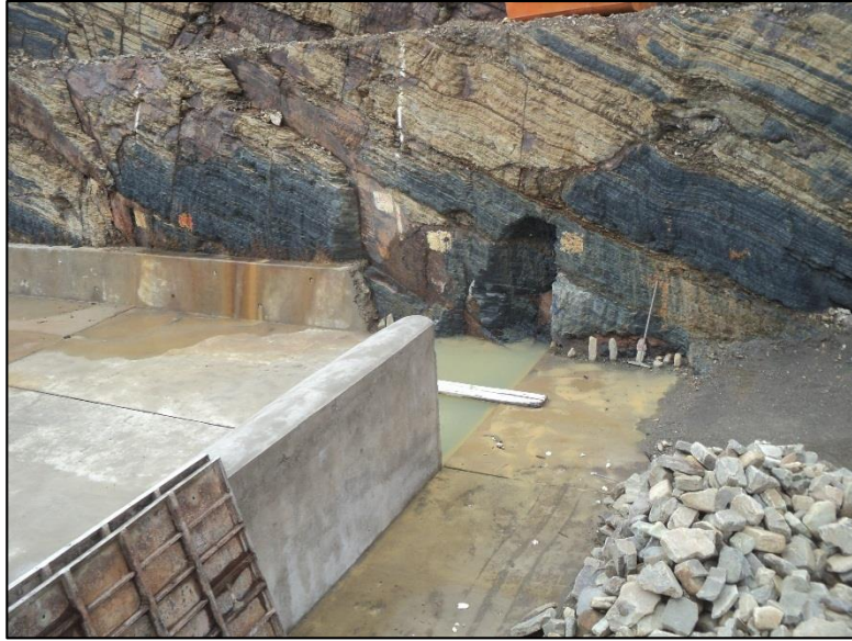
Fotografía 9. Vertedero de excedencias y Canal de descarga
