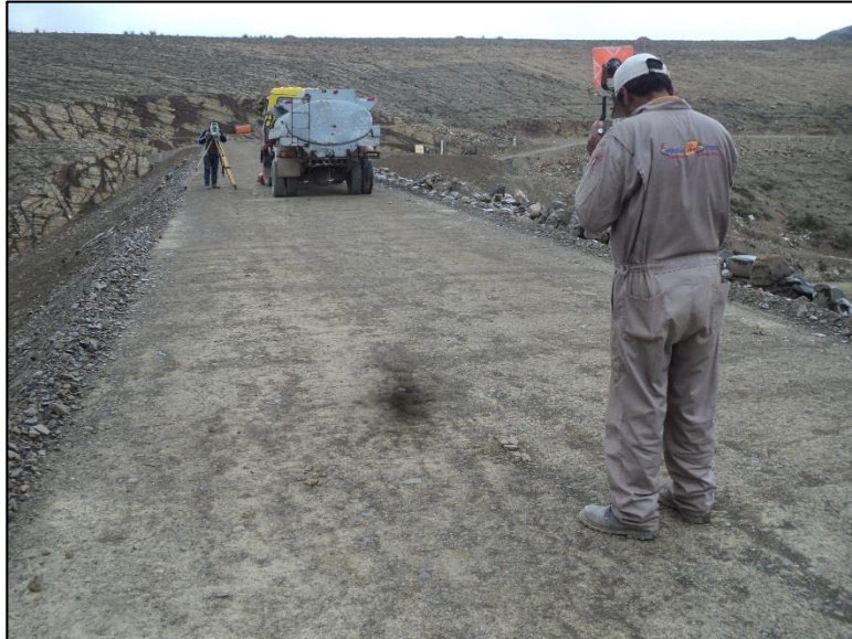
Fotografía 12. Coronamiento de la Presa
