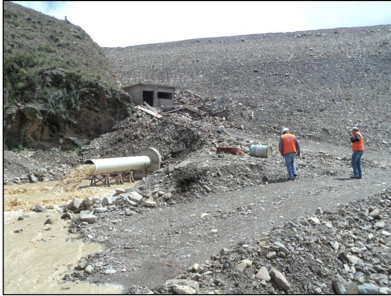
Fotografía 11. Desfogue Aguas abajo de la Presa
