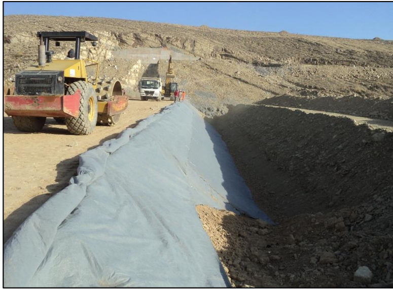
Fotografía 3. Provisión y Colocado Geo textil (Aguas Arriba)
