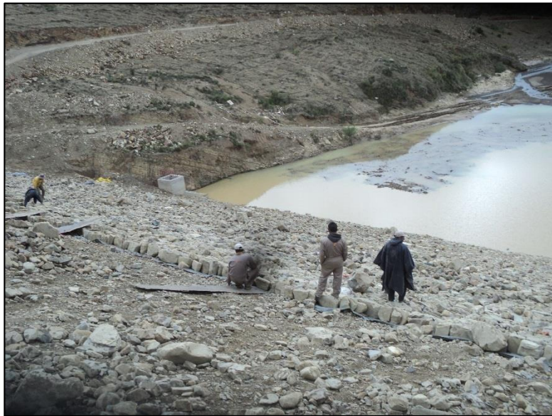
Fotografía 10. Rip Rap talud aguas arriba
