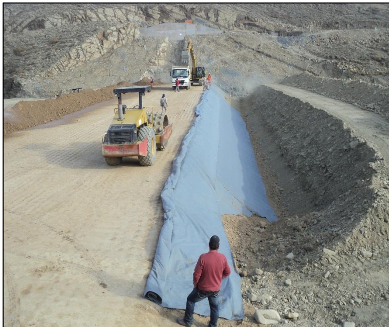
Fotografía 4. Provisión y Colocado de Geo textil (Aguas Abajo)
