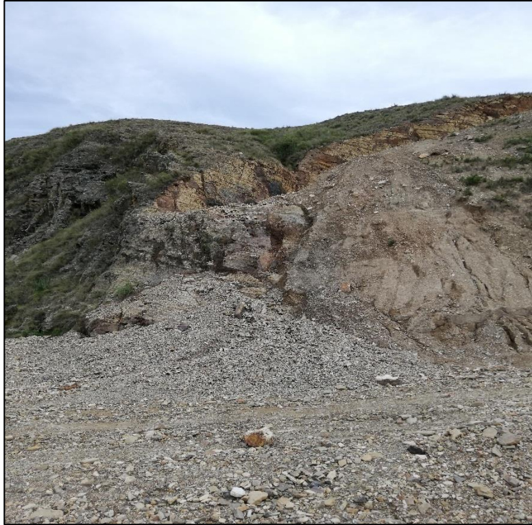
Fotografía 17. Salida del vertido aguas abajo de la presa
