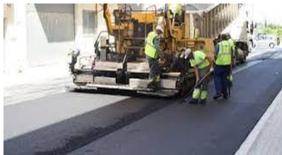
Figura 2.2. Aplicación de una mezcla en frío
