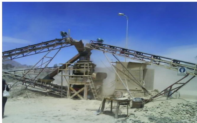
Figura 3.2. Planta de áridos
