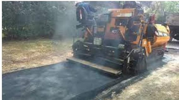
Figura 2.1. Aplicación de una mezcla en caliente
