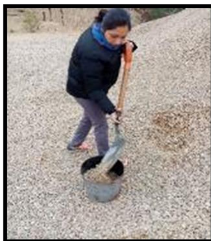
Figura 4.7 Acopio de grava.
