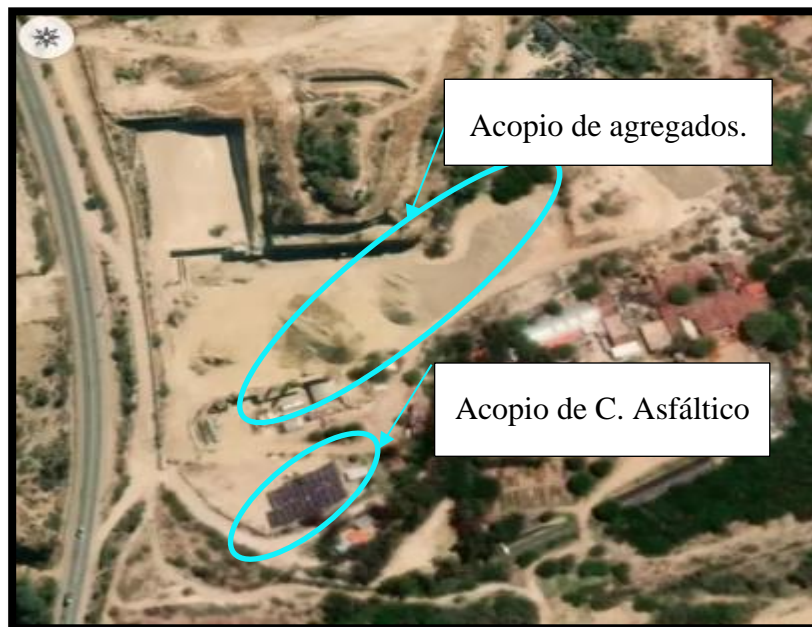
Figura 4.5 Ubicación planta asfáltica C.I.B.E.R de la Alcaldía Municipal de Tarija-La Pintada.
