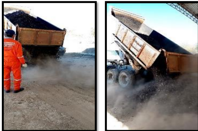
Figura 4.47 Acopio de RAP
