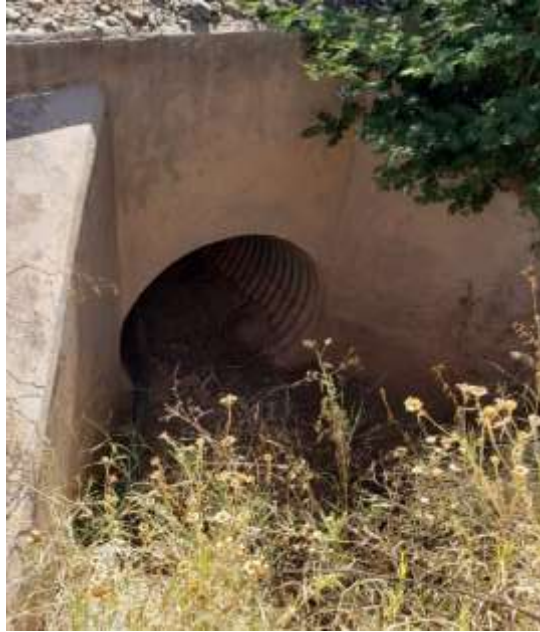
Entrada de la alcantarilla
