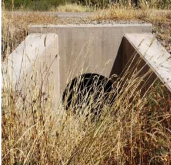
Salida de la alcantarilla
