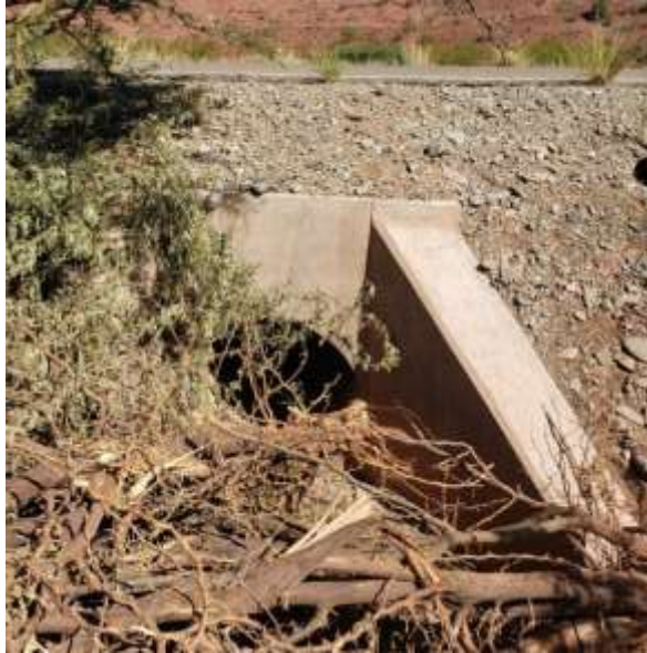
Salida de la alcantarilla
