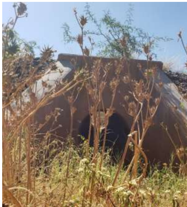
Salida de la alcantarilla
