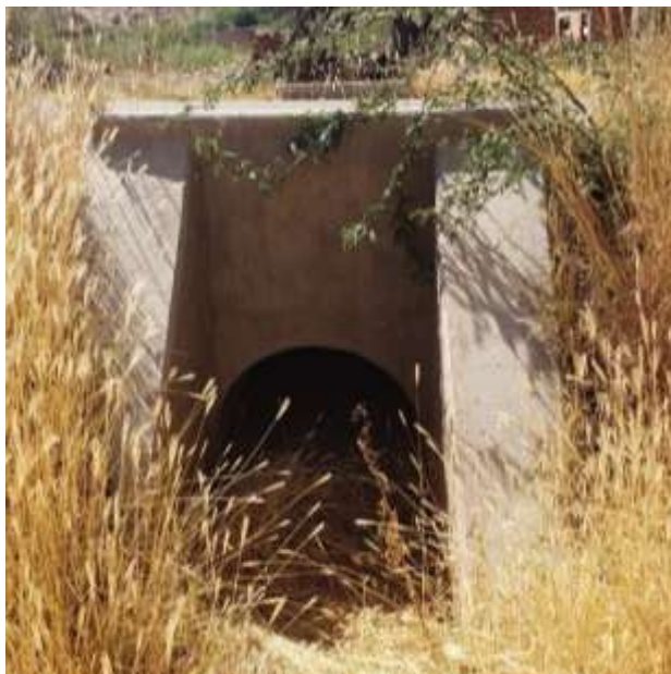
Salida de la alcantarilla
