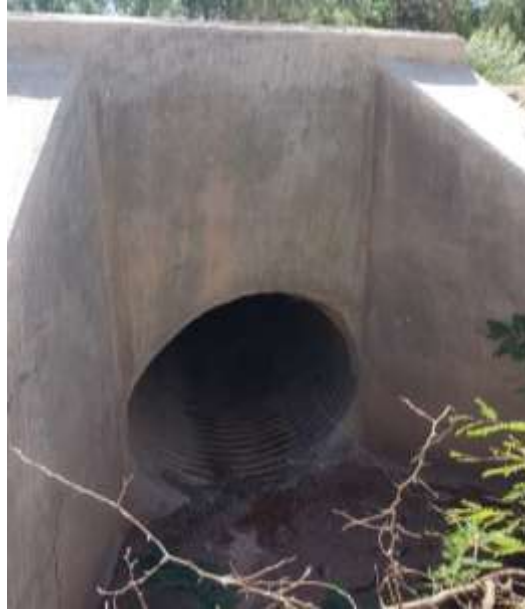
Salida de la alcantarilla
