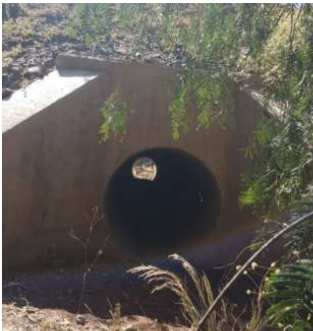
Salida de la alcantarilla
