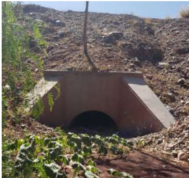
Salida de la alcantarilla
