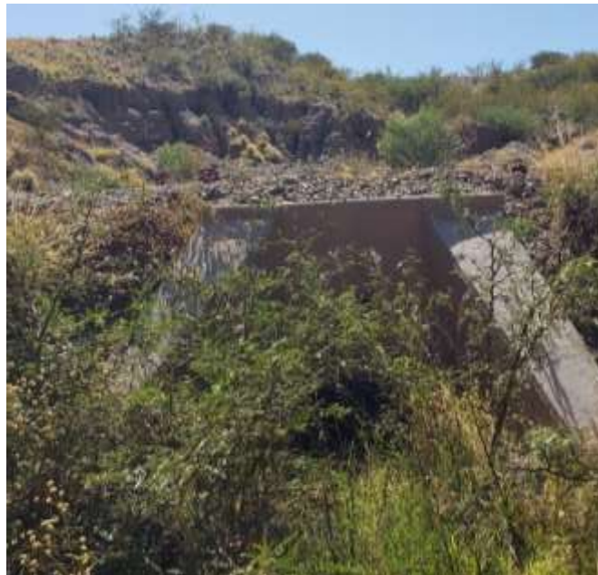
Salida de la alcantarilla
