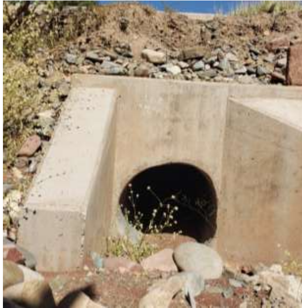
Entrada de la alcantarilla
