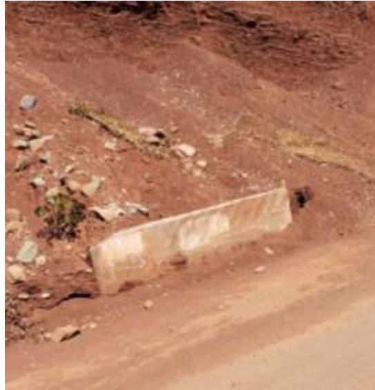
Entrada de la alcantarilla
