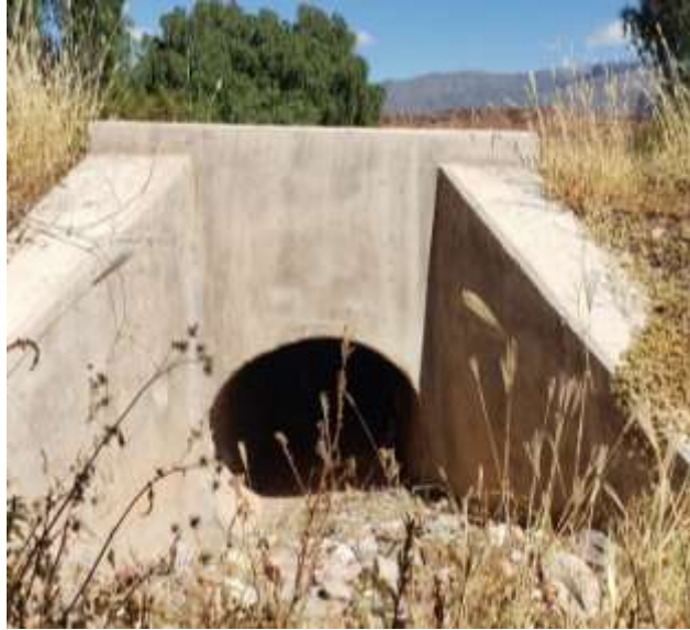
Entrada de la alcantarilla
