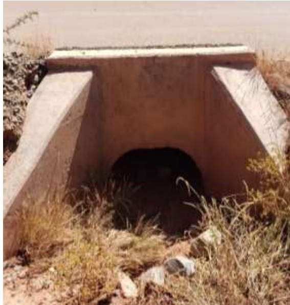
Entrada de la alcantarilla
