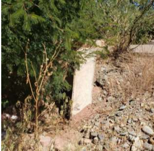
Entrada de la alcantarilla
