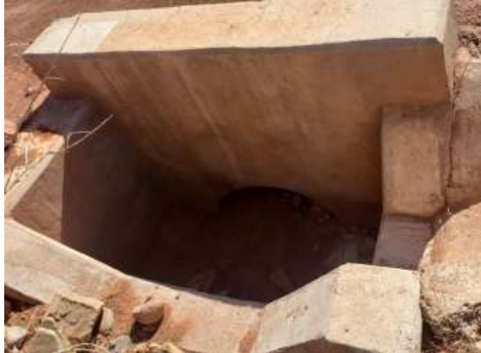
Entrada de la alcantarilla
