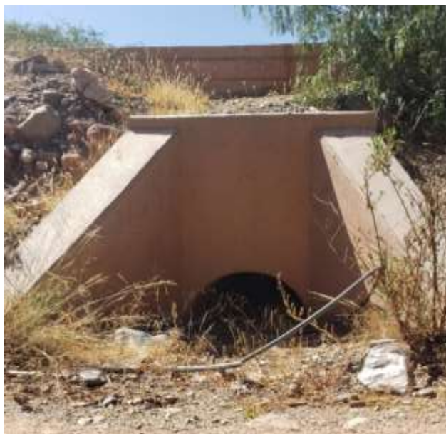
Salida de la alcantarilla
