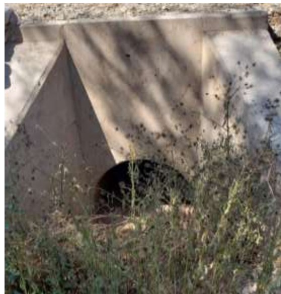
Salida de la alcantarilla
