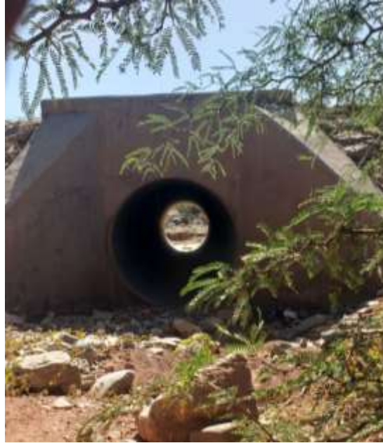
Entrada de la alcantarilla
