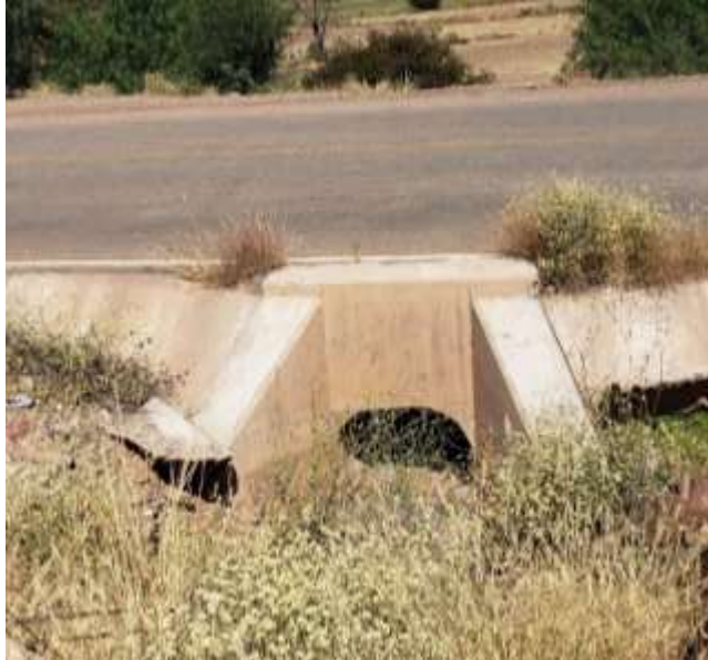
Entrada de la alcantarilla
