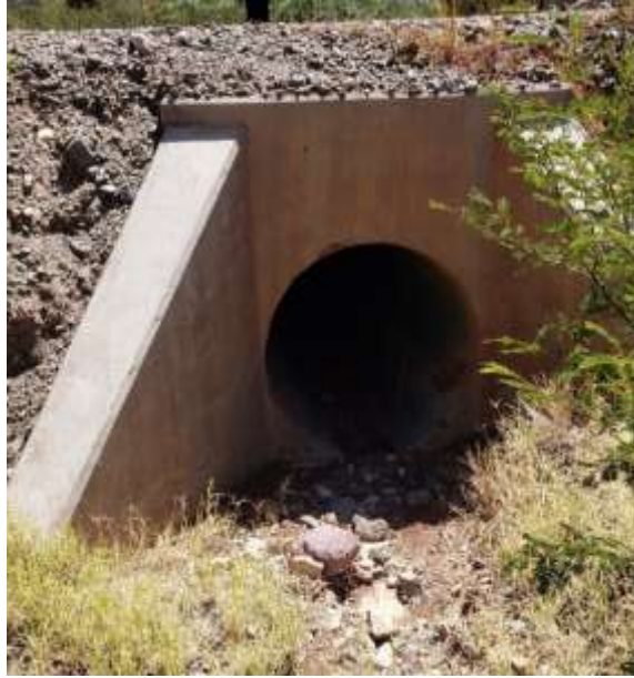
Salida de la alcantarilla
