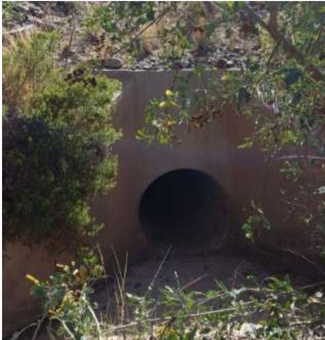
Salida de la alcantarilla
