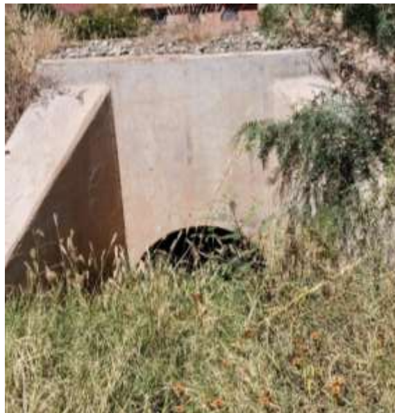
Salida de la alcantarilla
