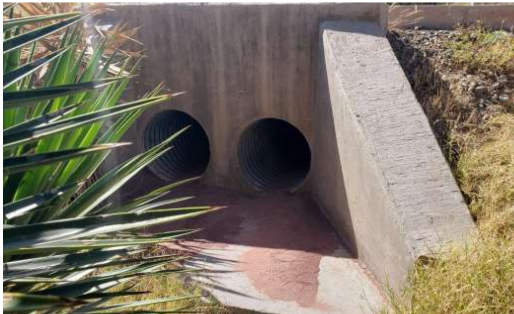
Salida de la alcantarilla
