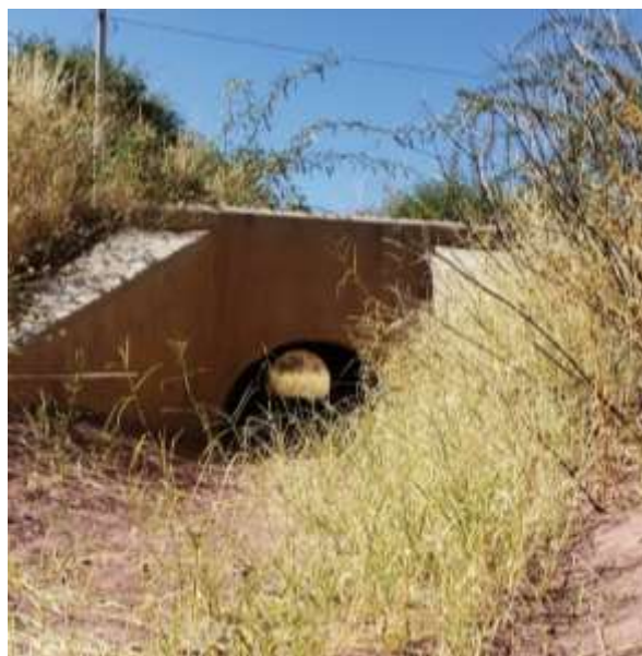
Salida de la alcantarilla
