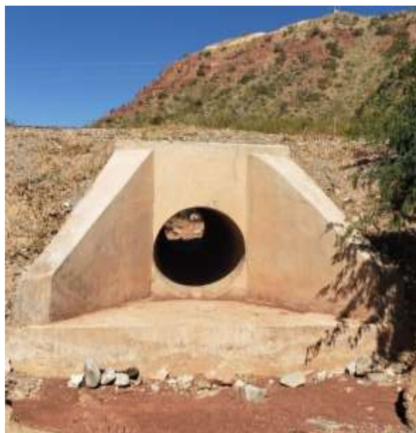
Salida de la alcantarilla.
