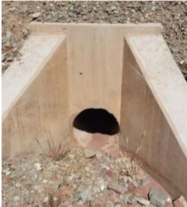
Salida de la alcantarilla
