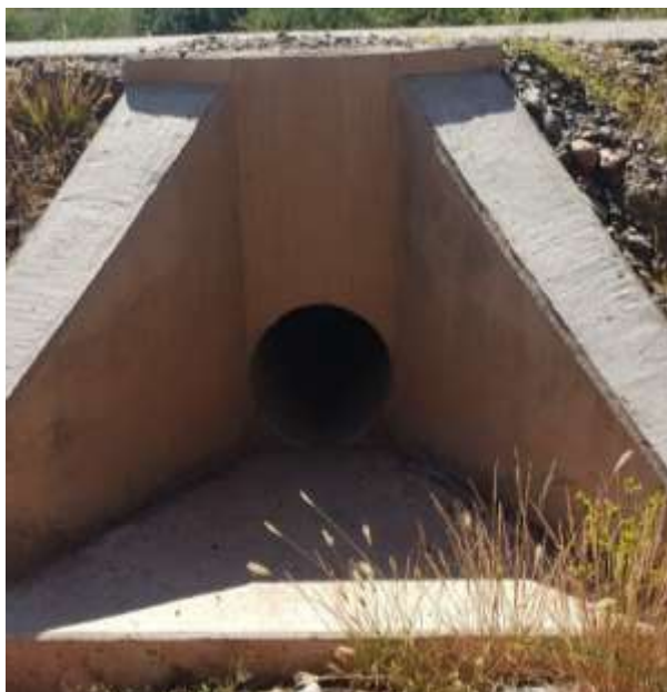
Salida de la alcantarilla
