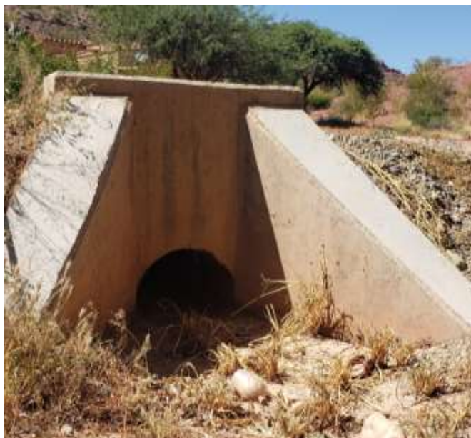
Salida de alcantarilla
