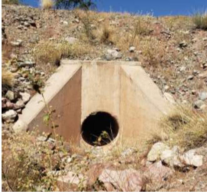
Entrada de la alcantarilla
