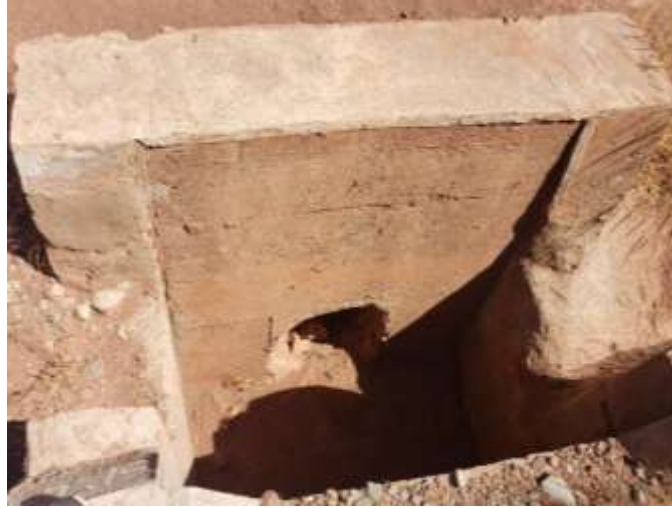
Entrada de la alcantarilla
