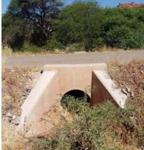
Entrada de la alcantarilla
