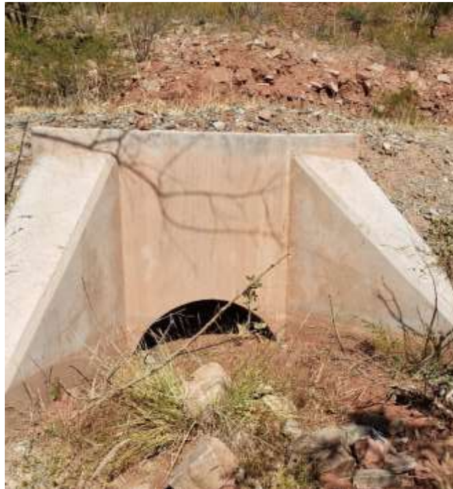
Salida de la alcantarilla
