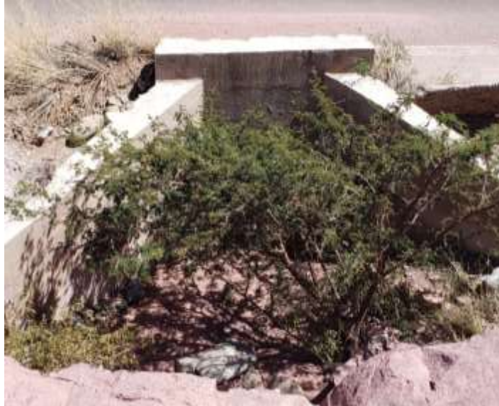
Entrada de la alcantarilla
