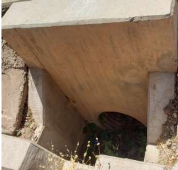
Salida de la alcantarilla
