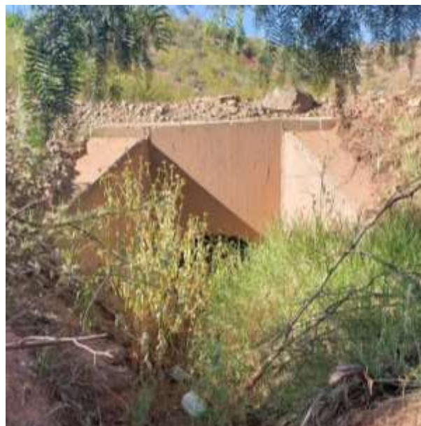
Salida de la alcantarilla
