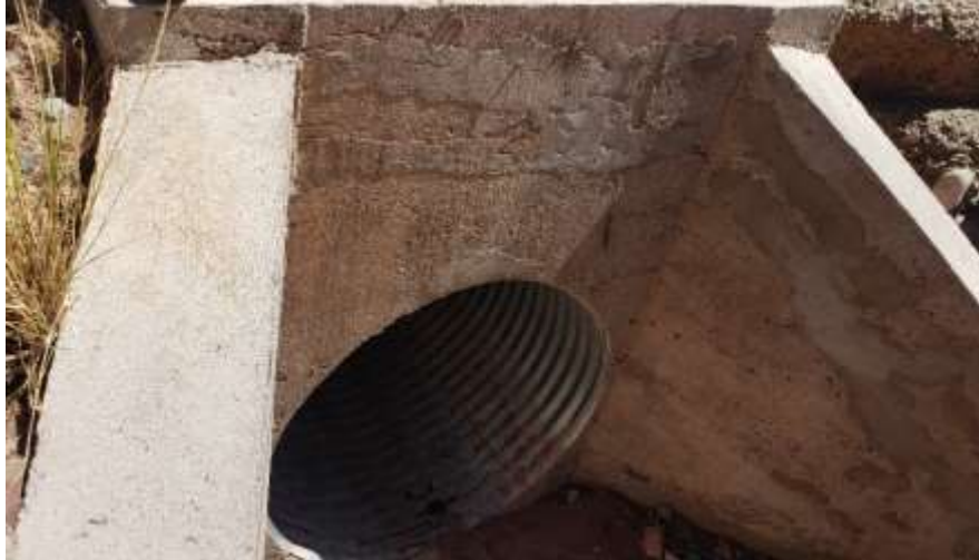
Entrada de la alcantarilla
