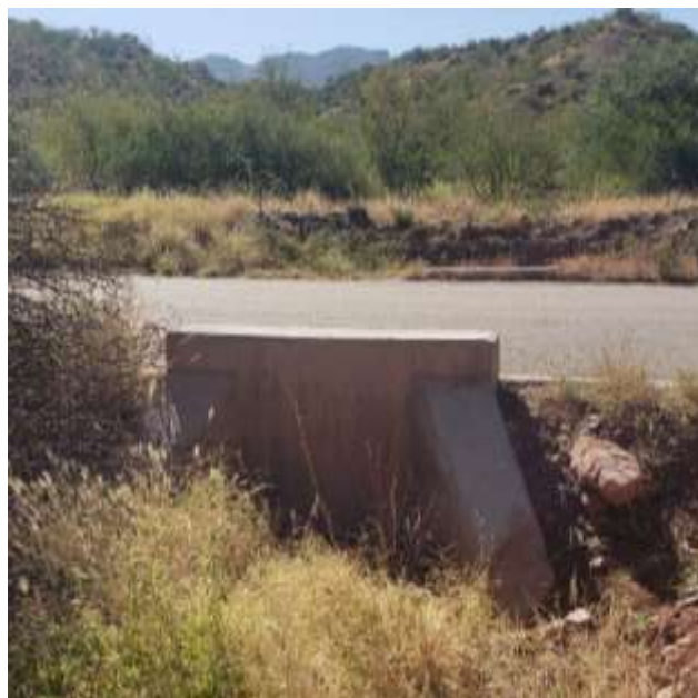
Salida de la alcantarilla
