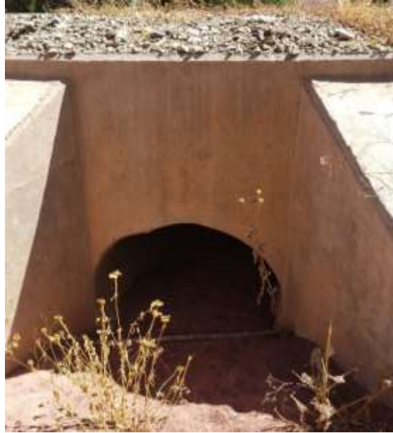
Salida de la alcantarilla
