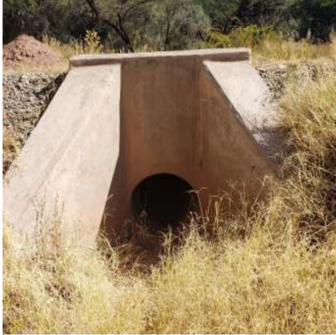
Salida de la alcantarilla
