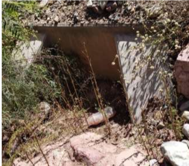
Entrada de la alcantarilla
