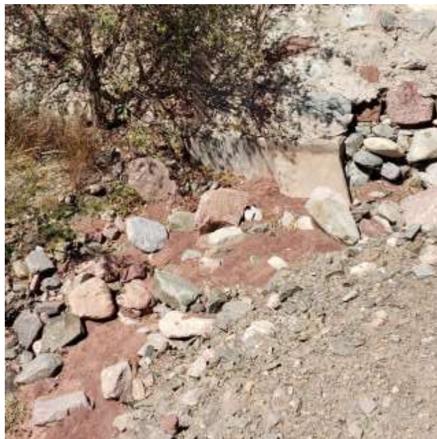
Salida de la alcantarilla
