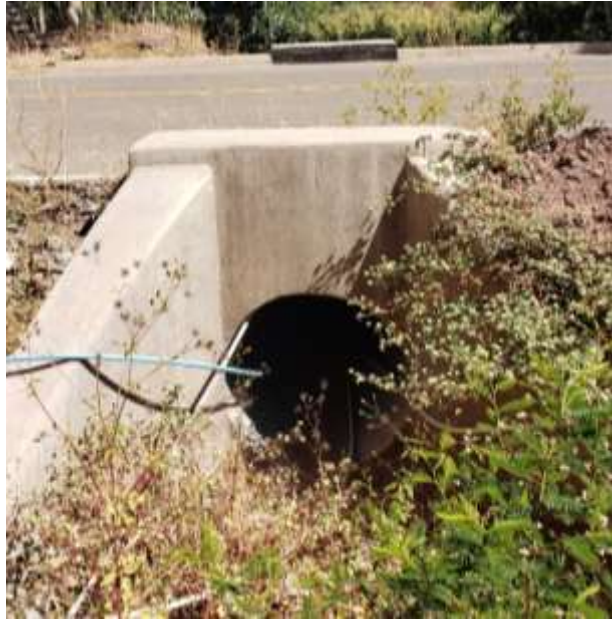
Salida de la alcantarilla
