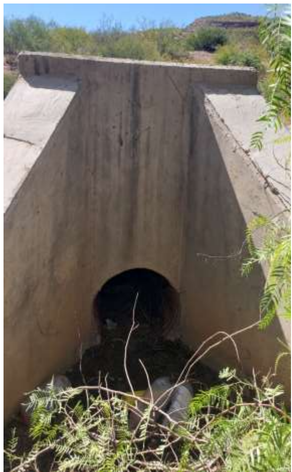
Entrada y salida de la alcantarilla
