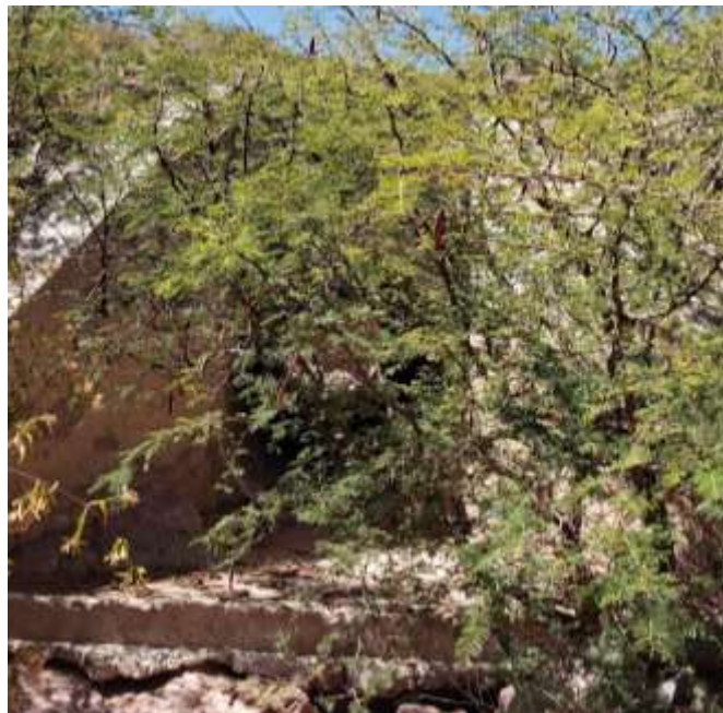
Salida de la alcantarilla
