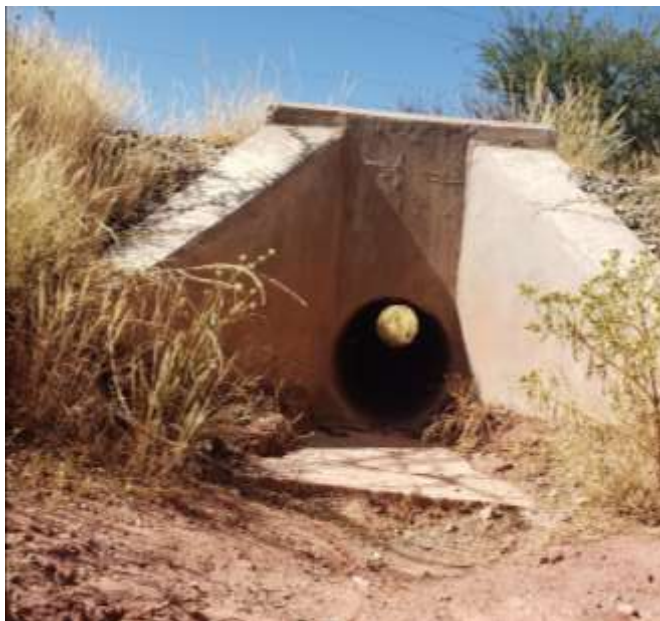
Salida de la alcantarilla
