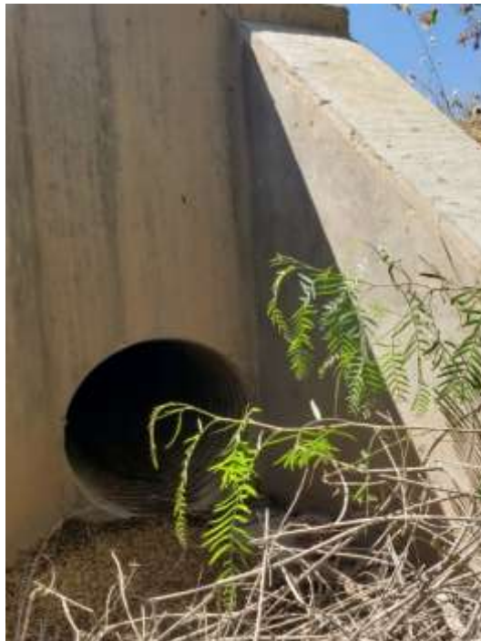
Salida de la alcantarilla
