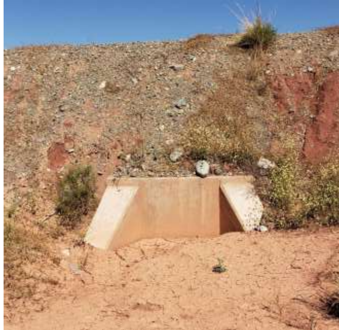
Entrada de la alcantarilla
