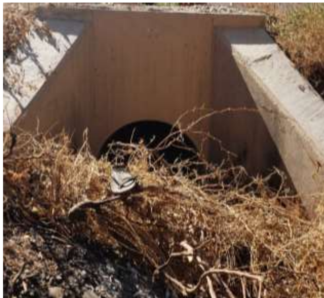
Salida de la alcantarilla
