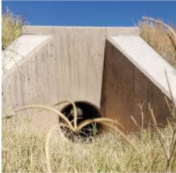
Entrada de la alcantarilla
