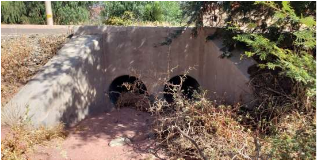
Entrada de la alcantarilla
