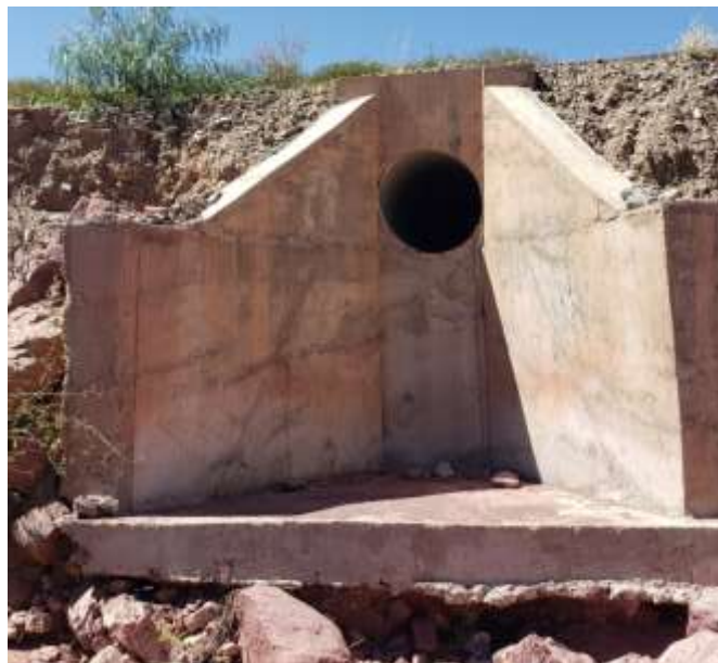
Salida de la alcantarilla
