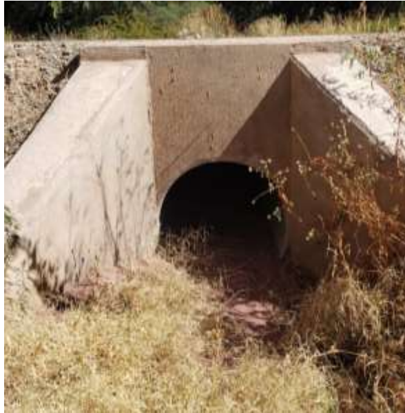
Salida de la alcantarilla
