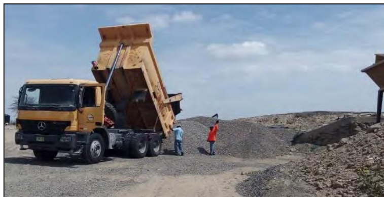
Figura 4.1. Acopio de los agregados pétreos en la planta de asfalto.
