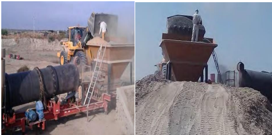
Figura 4.2 Alimentación de tolva con arena y piedra chancada 1/2”.
