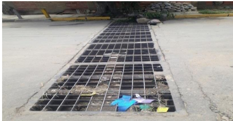
Figura 2.23 Sumidero en calzada
