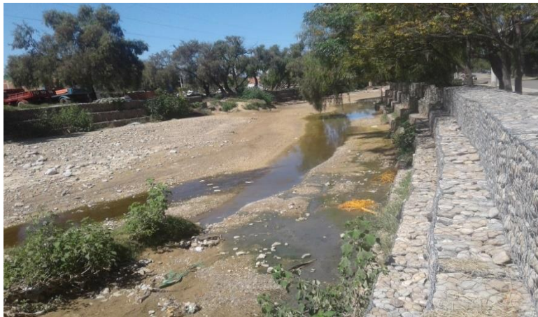
Figura 2.7 Quebrada el Monte
