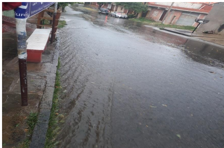
Figura 2.8 Cuneta conduciendo agua superficial
