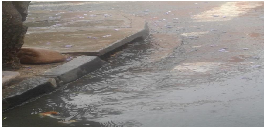
Figura 2.1 Captación de agua de lluvia mediante un sumidero
