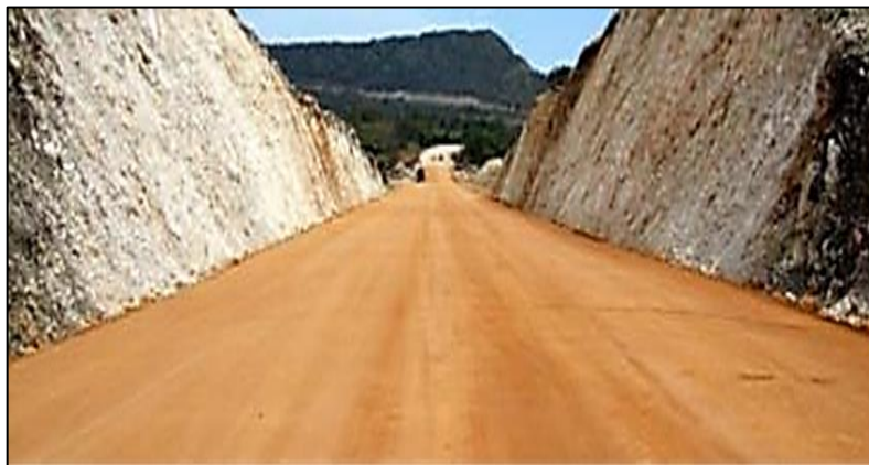
Figura 2.3 Subrasante de terreno
