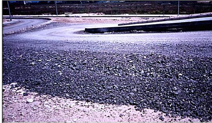
Figura 2.4 Aspecto de capa base en obra
