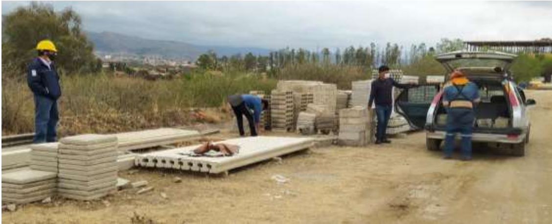
Recogiendo las losetas de hormigón de la planta
