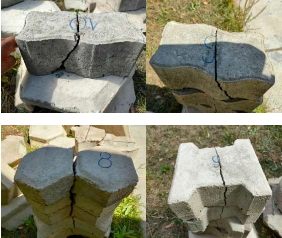
Losetas almacenadas después de haber realizado el ensayo de resistencia a flexión
