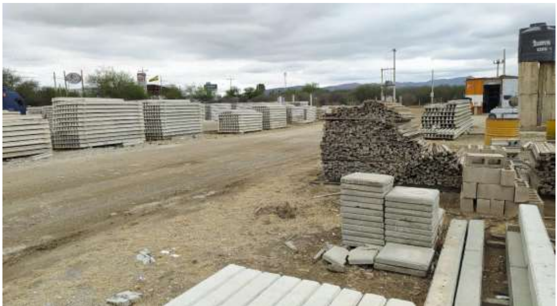
Planta de la empresa nacional Concrettec Tarija
