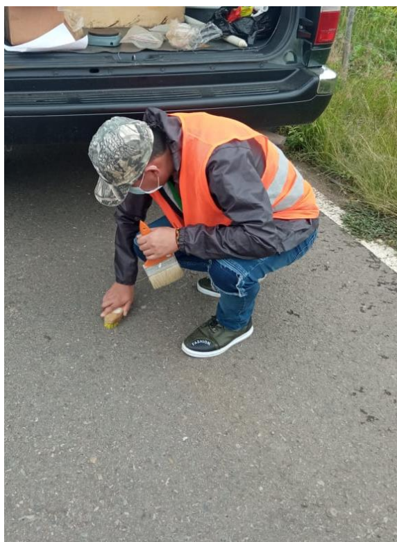
Figura N° 15 Limpieza de la superficie del pavimento
