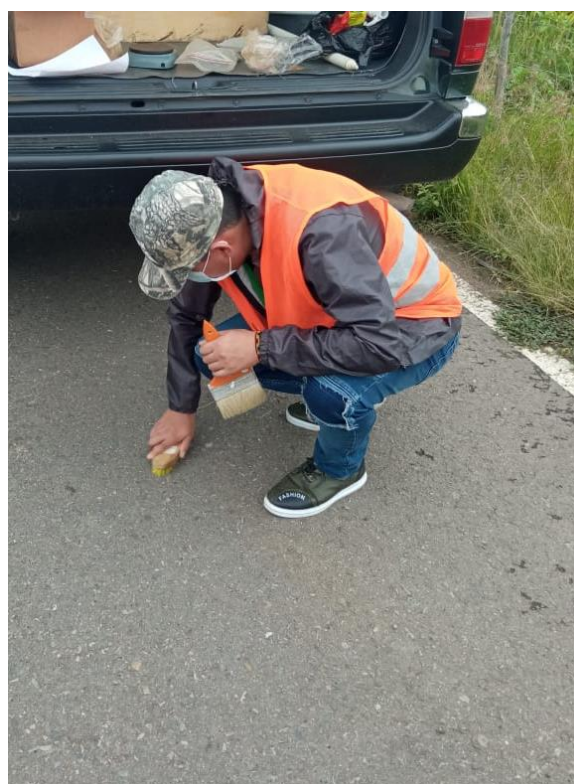
Figura N° 15 Limpieza de la superficie del pavimento
