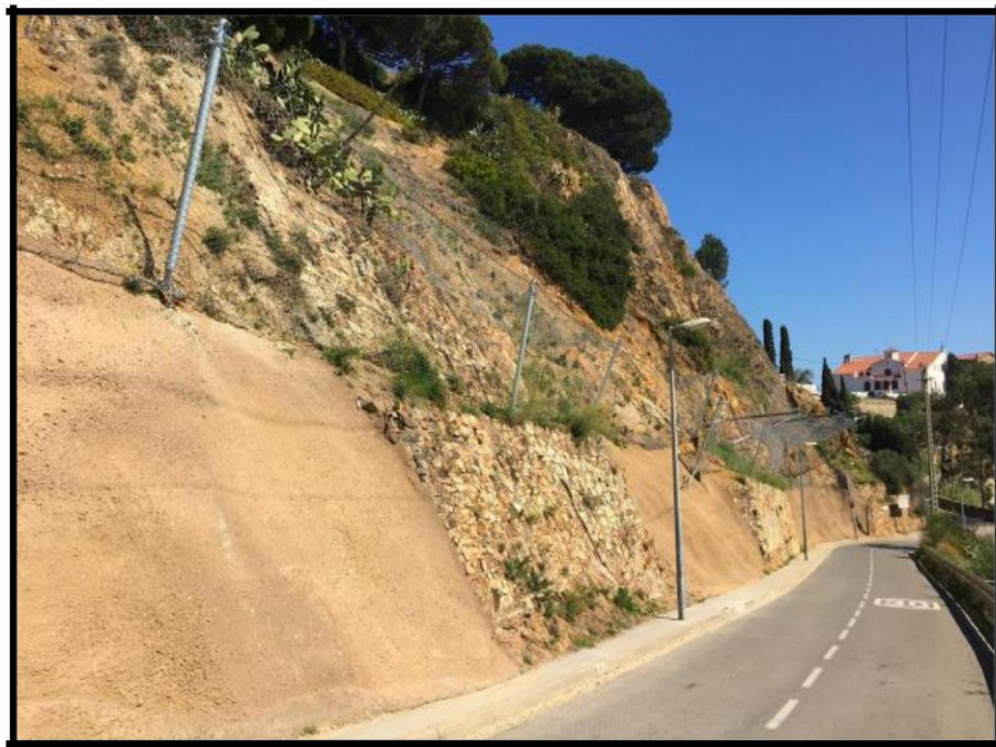
Figura 2.25. Consolidación de taludes con barrera de malla de alambre
