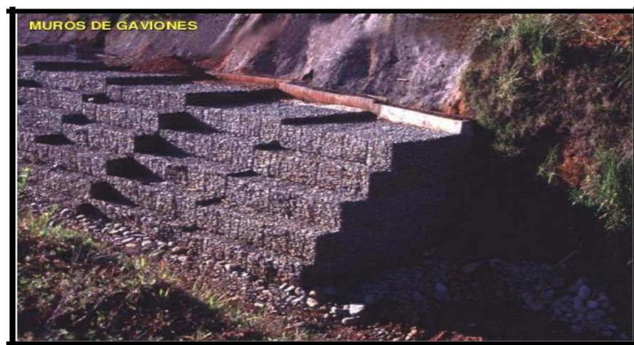
Figura 2.28. Muro de Gaviones
