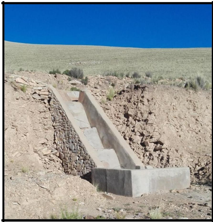
Figura 4.25. Canal colector de aguas junto a una bajante de aguas
