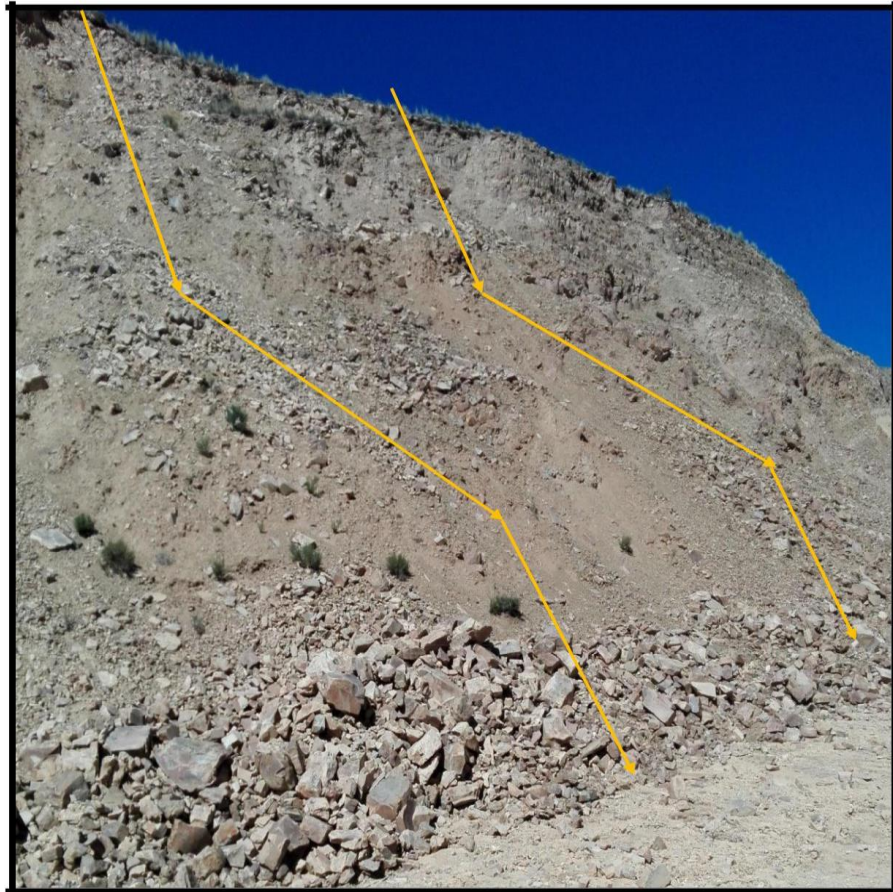
Figura 4.27. Alternativa de corte para el talud 1
