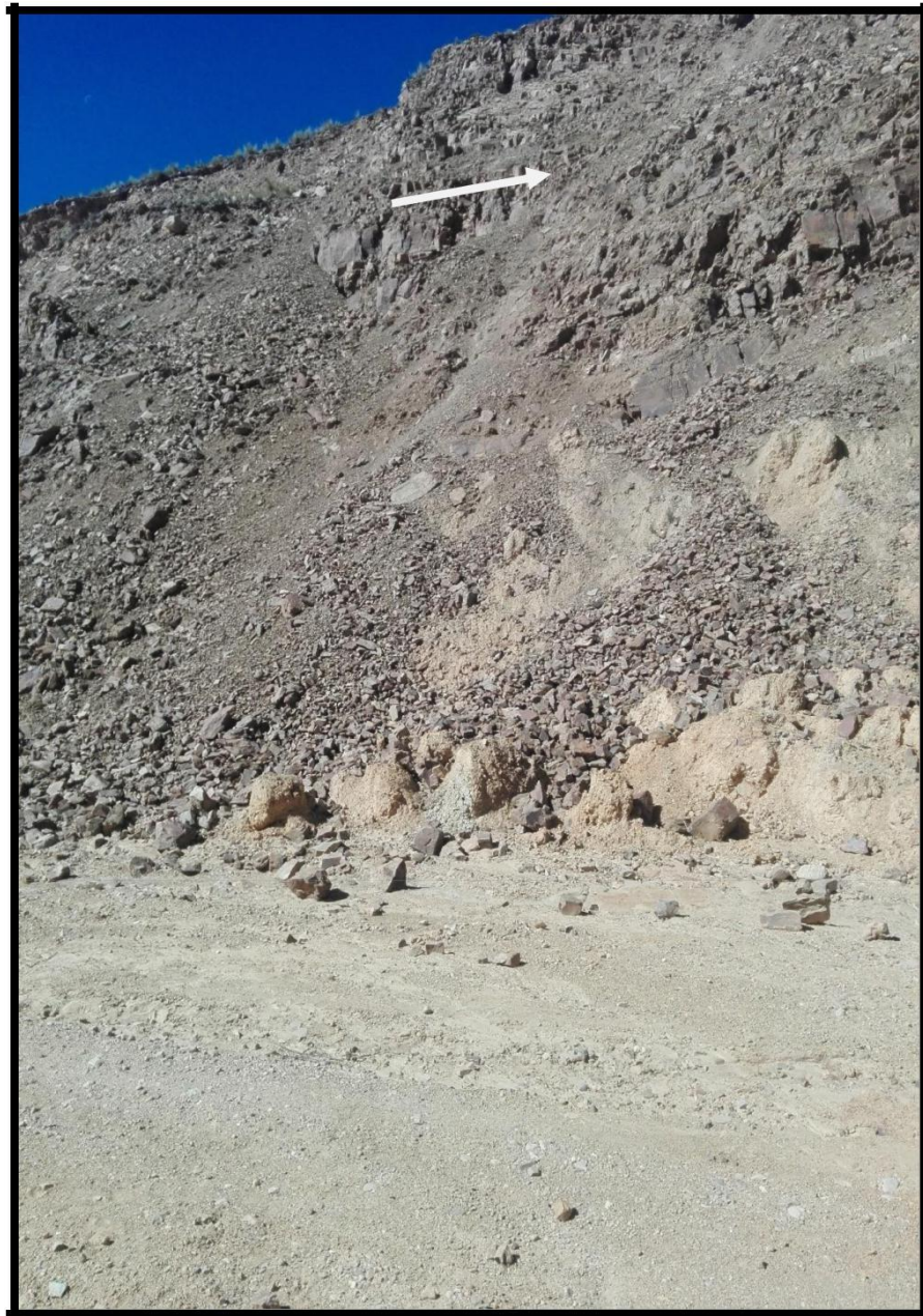
Figura 3.6. Talud estratificado inestable
