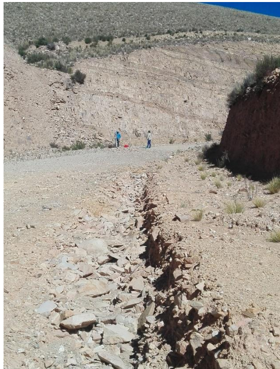
Fallas que se presentan en los taludes
