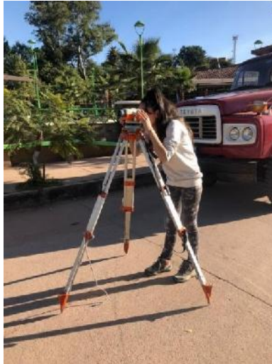
Figura 3.23 Armado del Nivel de ingeniero.
