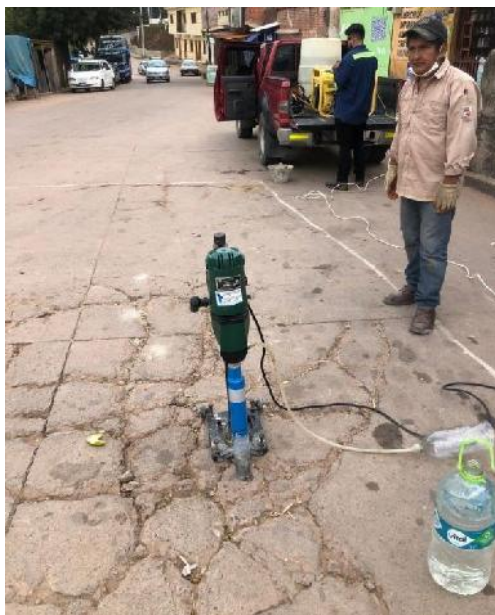
Figura 3.36 Extracción de testigo (Entre Ríos).
