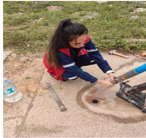
Figura 3.146 Extracción de testigos
