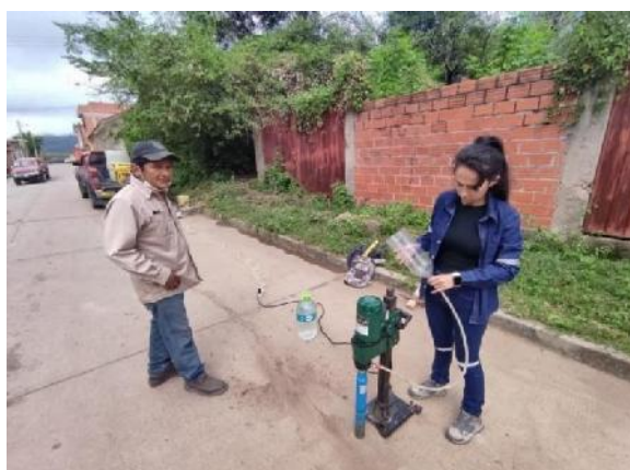
Figura 3.31 Equipo de extracción de testigos.
