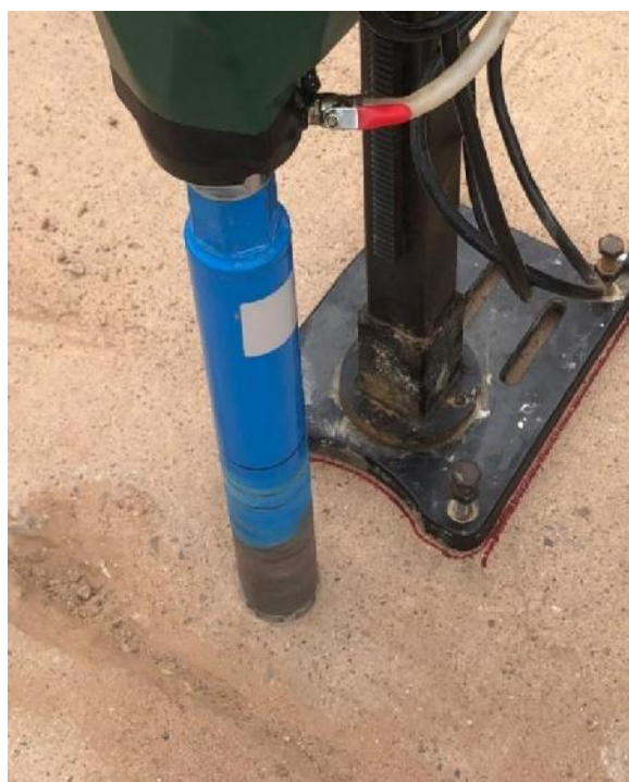
Figura 3.33 Equipo de extracción de testigos (Broca).
