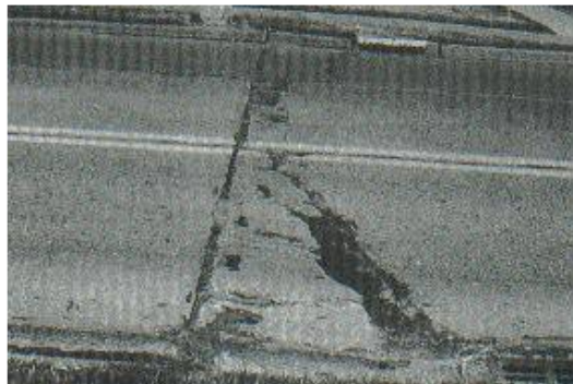
Figura 2.2.3.14 b) Punzonamiento de severidad media.
