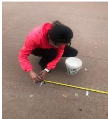
Figura 3.22 Marcado del pavimento a cada 500 mm.
