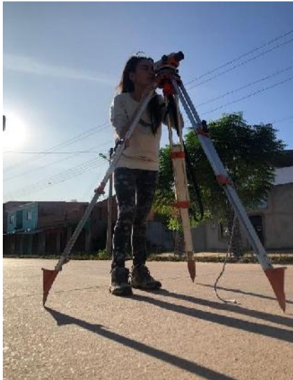
Figura 3.24 Armado del Nivel de ingeniero.
