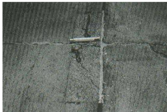
Figura 2.2.3.10 c) Parche pequeño de alta severidad.
