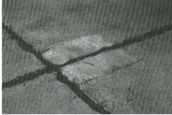
Figura 2.2.3.10 a) Parche pequeño de baja severidad.
