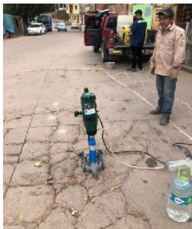
Figura 3.144 Extracción de testigos
