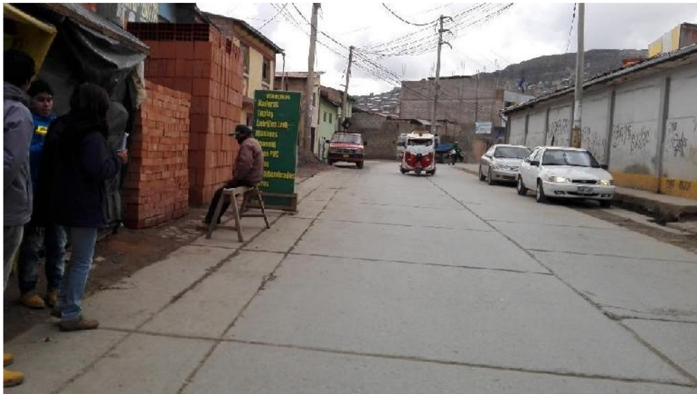
Figura 2.2 Superficie de pavimento de concreto rígido.
