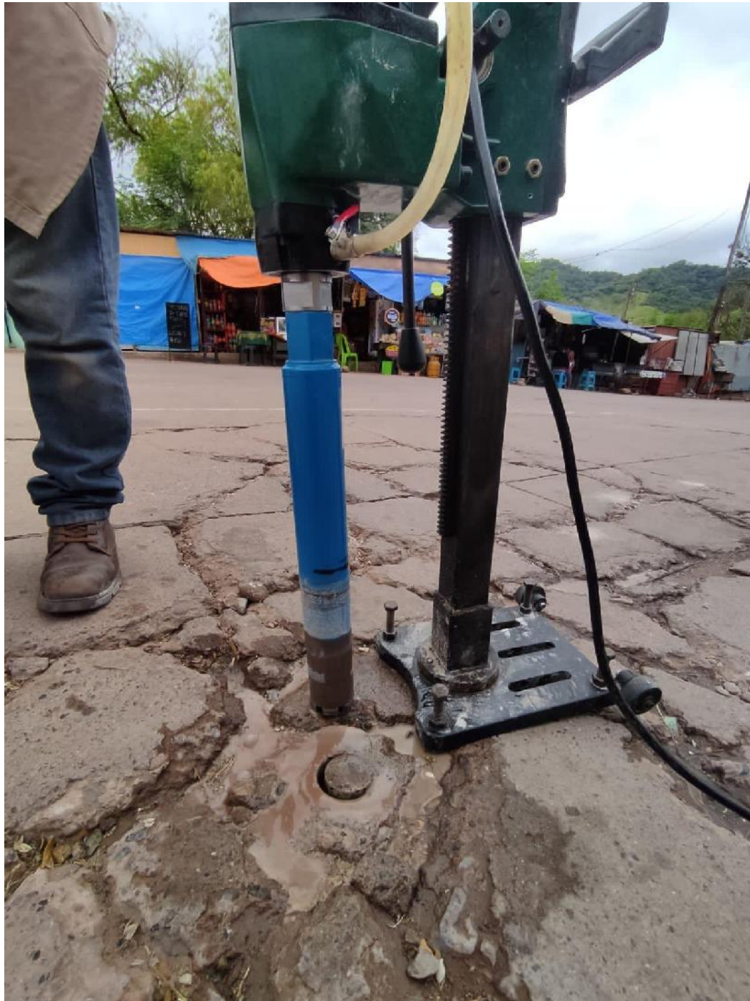
Figura 3.38 Extracción de testigo (Entre Ríos).
