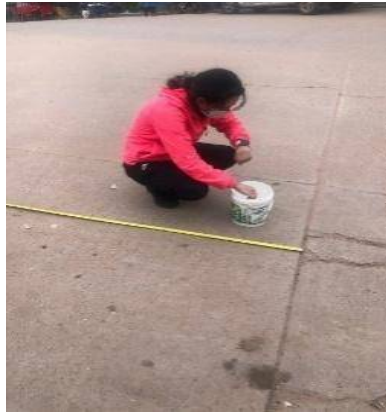
Figura 3.21 Marcado del pavimento a cada 500 mm.
