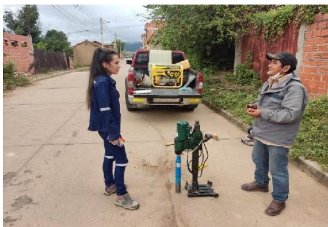
Figura 3.32 Equipo de extracción de testigos.
