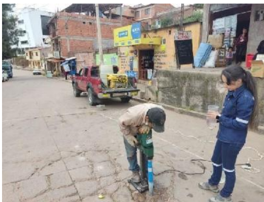
Figura 3.37 Extracción de testigo (Entre Ríos).
