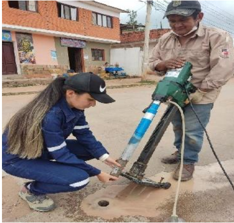
Figura 3.145 Extracción de testigos
