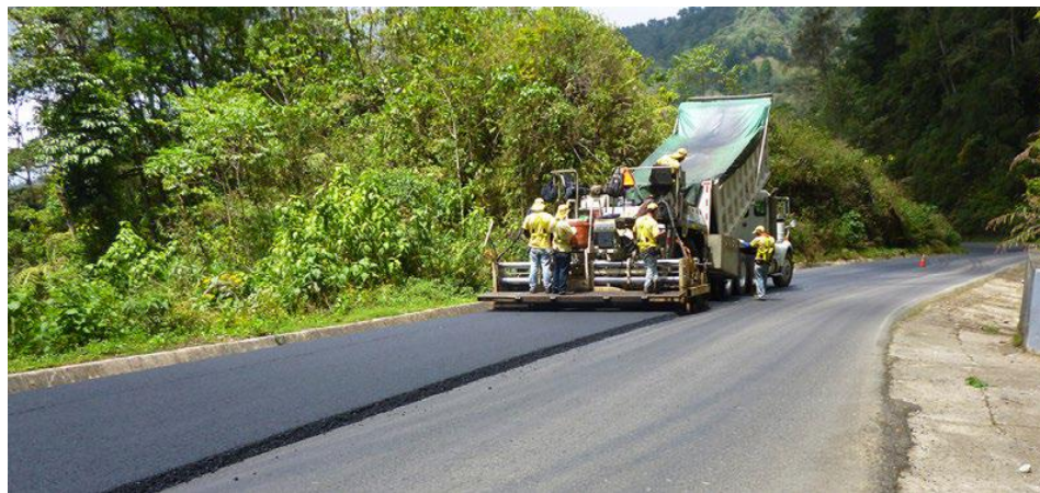
Figura 2.37: Colocación de la sobrecapa asfáltica
