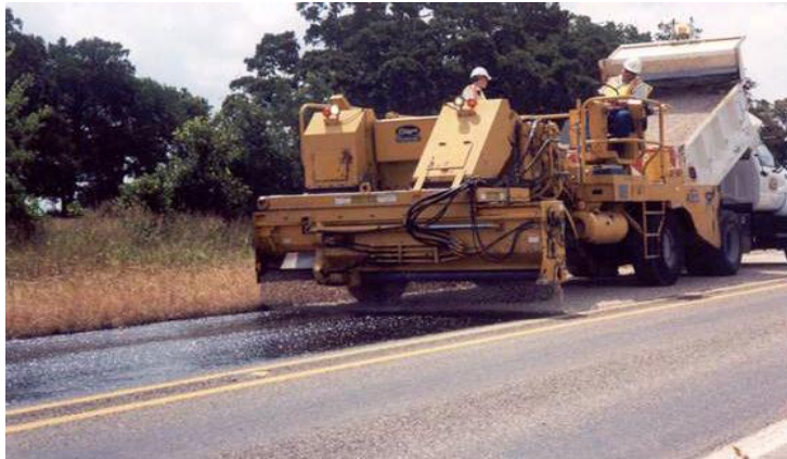
Figura 2.41: Distribución de los agregados
