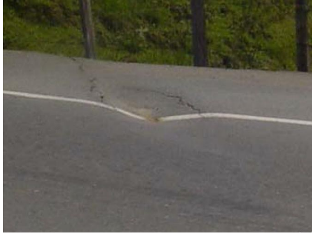
Figura 2.16: Hundimiento
