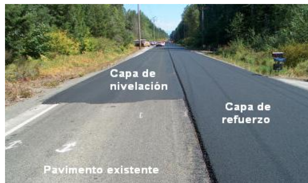
Figura 2.29: Capa de nivelación previa a una capa de refuerzo
