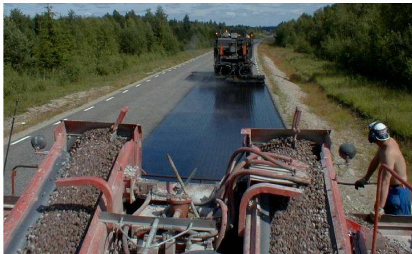
Figura 2.33: Restauración de un pavimento asfáltico con un tratamiento superficial
