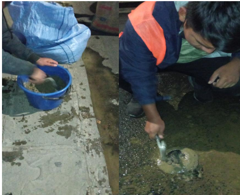
Figura 3.26: Preparación del material y llenado del lugar de extracción
