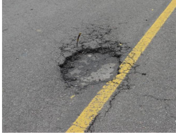
Figura 2.18: Descascaramiento
