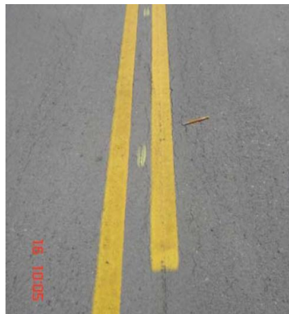
Figura 2.13: Fisuración incipiente
