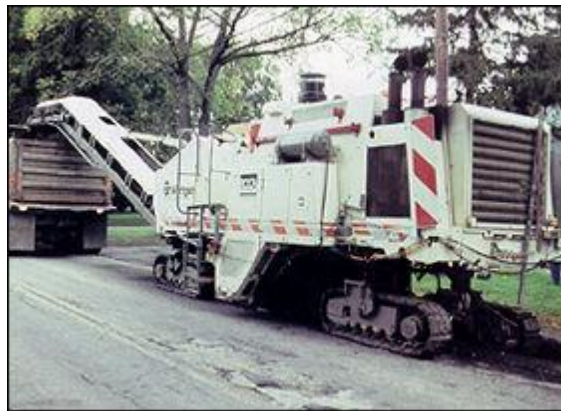
Figura 2.30: Fresado de un pavimento asfáltico
