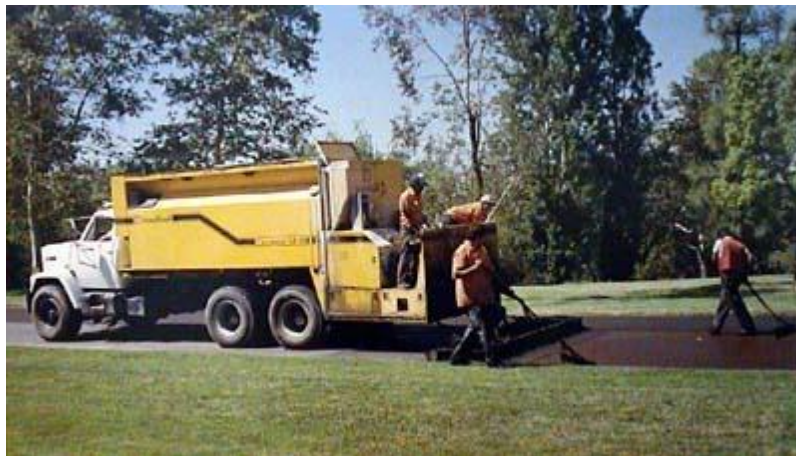
Figura 2.34: Restauración de un pavimento con una lechada asfáltica
