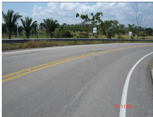
Figura 2.21: Desgaste superficial
