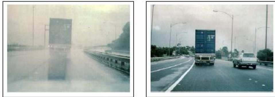
Figura 2.35: Diferencia de visibilidad en instantes de lluvia, al circular sobre una superficie de concreto asfáltico y una de mezcla drenante
