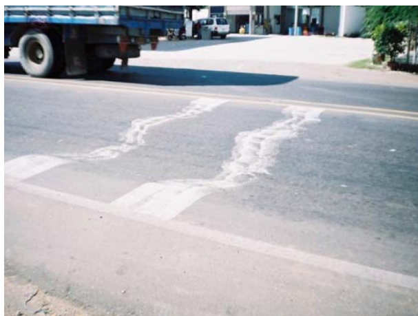
Figura 2.17: Ahuellamiento
