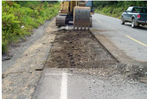
Figura 2.28: Excavación para el parcheo de un pavimento asfáltico
