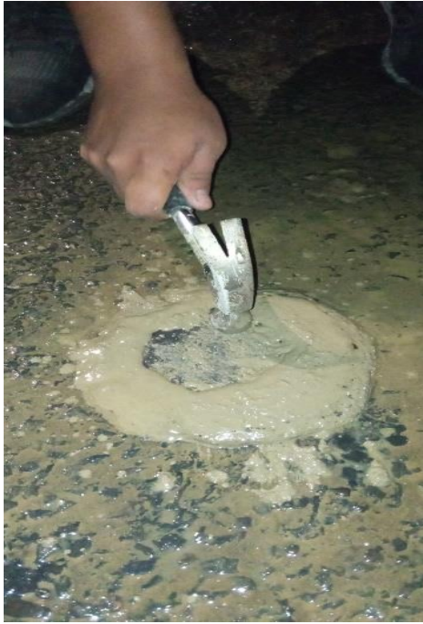
Tapado con mortero del hueco resultado de la extracción.
