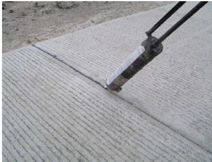
Figura 2.9: Colocación del sello en una junta transversal de contracción
